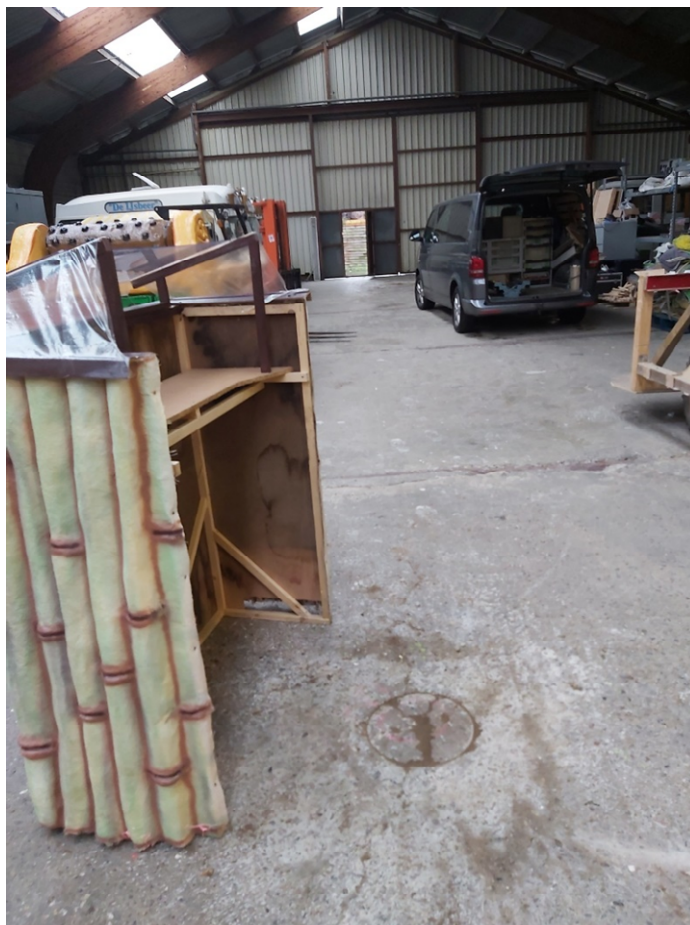
Inpandig, betonboring 350 mm
