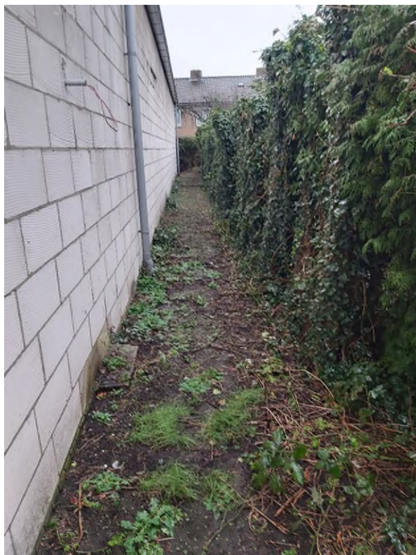
Strook naast voormalig asbestdak
