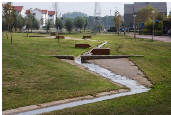
Figuur 12 Hemelwater afvoer (bron: Klimaatwarenhuis)
