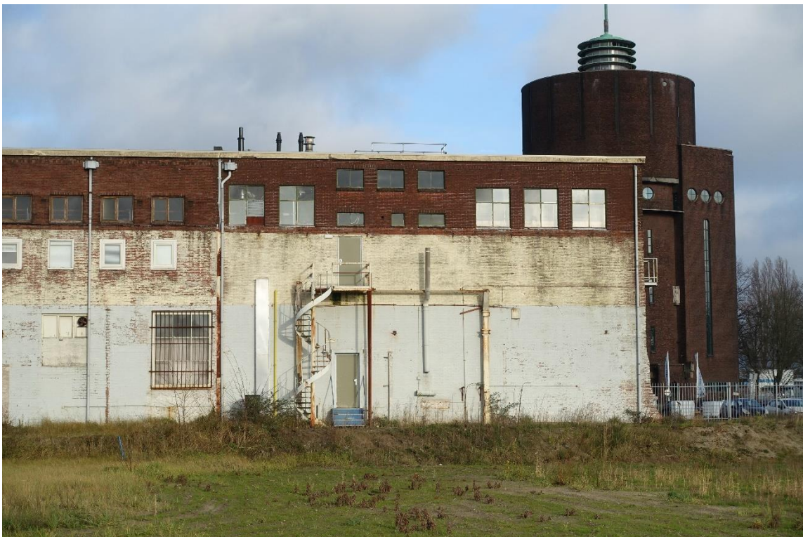
De rechterzijde van bovenstaand geveldeel. De drie grote vensters betreffen de voormalige tekenkamer die hiermee van veel daglicht werd voorzien. Daarnaast de travee met de lift, waarbij de bovenste vensters licht gaven aan de machinekamer.
