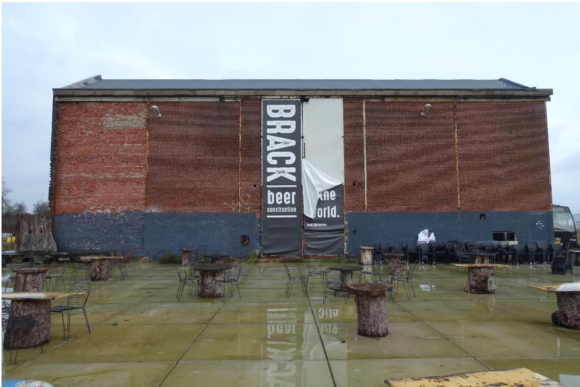
De korte, achtergevel aan de zijde van de haven. Het buitenblad aan de linkerzijde is verloren gegaan. De stalen stijlen verdelen de gevel in vijf vlakken, in het middelste stond een deuropening over de hele hoogte, deze is nu tijdelijk dichtgezet. De stalen raamwerken zijn nog aanwezig.
