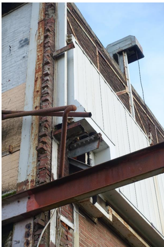
Beide foto's laten de afgebrande einden van de rolbaan zien. Het witte paneel kon via de heftorens worden opgetild zodat de rolkraan naar buiten kon. Op de opening het oorspronkelijke metselwerk met stalen stijlen en schoren.
