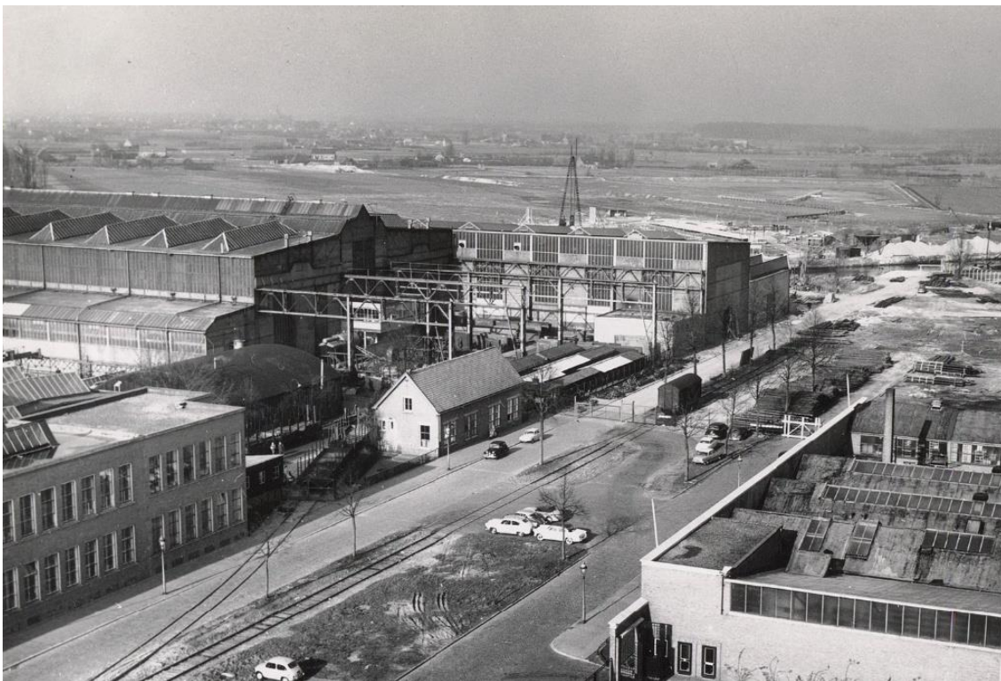
Op deze foto uit 1959 is de oudste bebouwing te zien. De rails gaat tussen het kantoorgebouwtje en het schaft- en waslokaal door. Rechts van het kantoorgebouwtje moet het portiersgebouw staan. De hal waarvan het grootste deel is te zien, is op de foto het oudste gebouw. Geheel rechts de voorgevel van de Lamonthallen.
