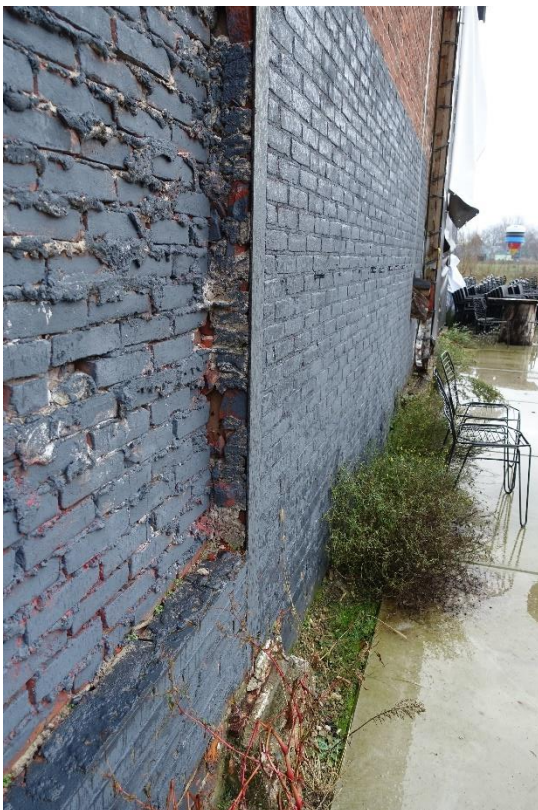
Links zicht op de opbouw van het metselwerk in de stijlen, beide bladen vielen tegen de flens. Rechts de hoek waar de stenen bekapt zijn om de stijl heen. Bij de pijl een spouwhaak.
