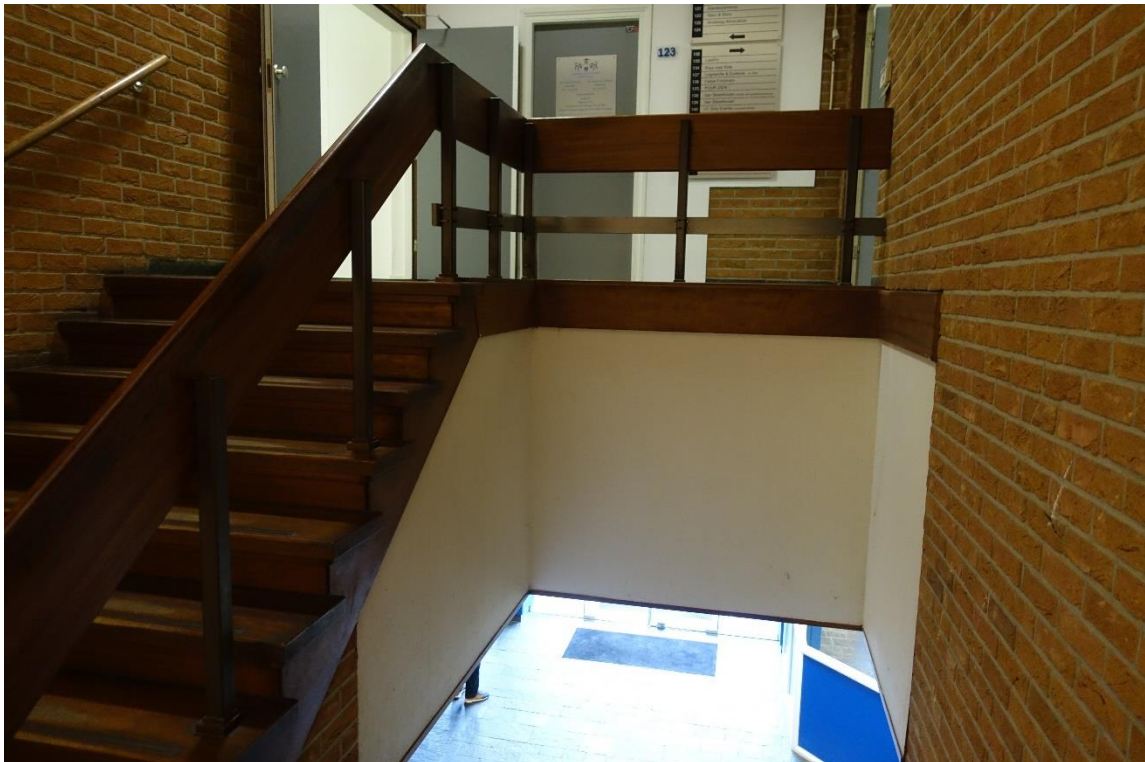
Het bovenste deel van de trap naar de verdieping. De witte aftimmering maskeert de forse verlaging van het plafond die bij de verbouwing is doorgevoerd.
