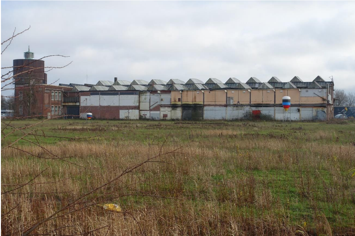
De buitengevel van de westelijke hal. In 1938 werd er nog een hal tegenaan gebouwd zodat de zichtbare gevel inpandig lag. De vele afwerklagen zijn hiervan het resultaat. Alleen de eerste travee, aan de zijde van het kantoor, was een buitengevel. Hier liep het spoor naar binnen via een grote deur.
