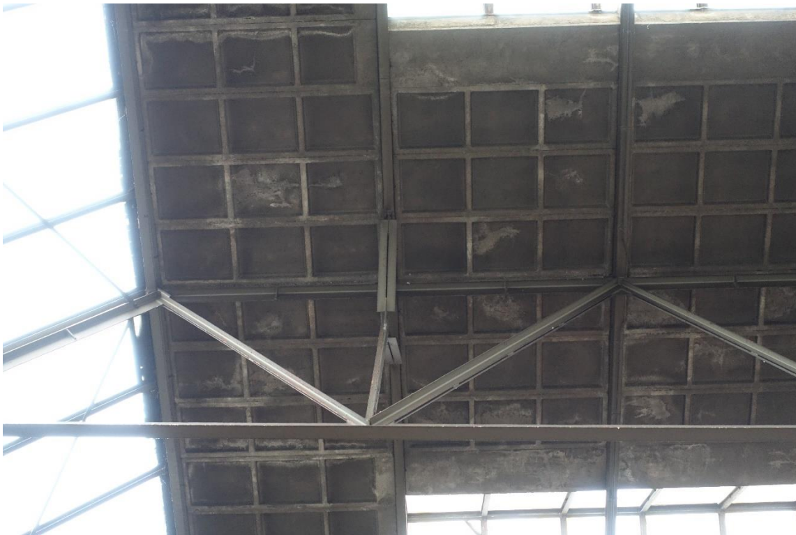
De kap van de oostelijke hal met de lichtstraat aan de zijkant van de vakwerkliggers. De Bimsbetonplaten hebben hier allemaal drie cassettes, ze zijn allemaal één cassette breed. De lichtrupsen staan op de afgestorte stroken.
