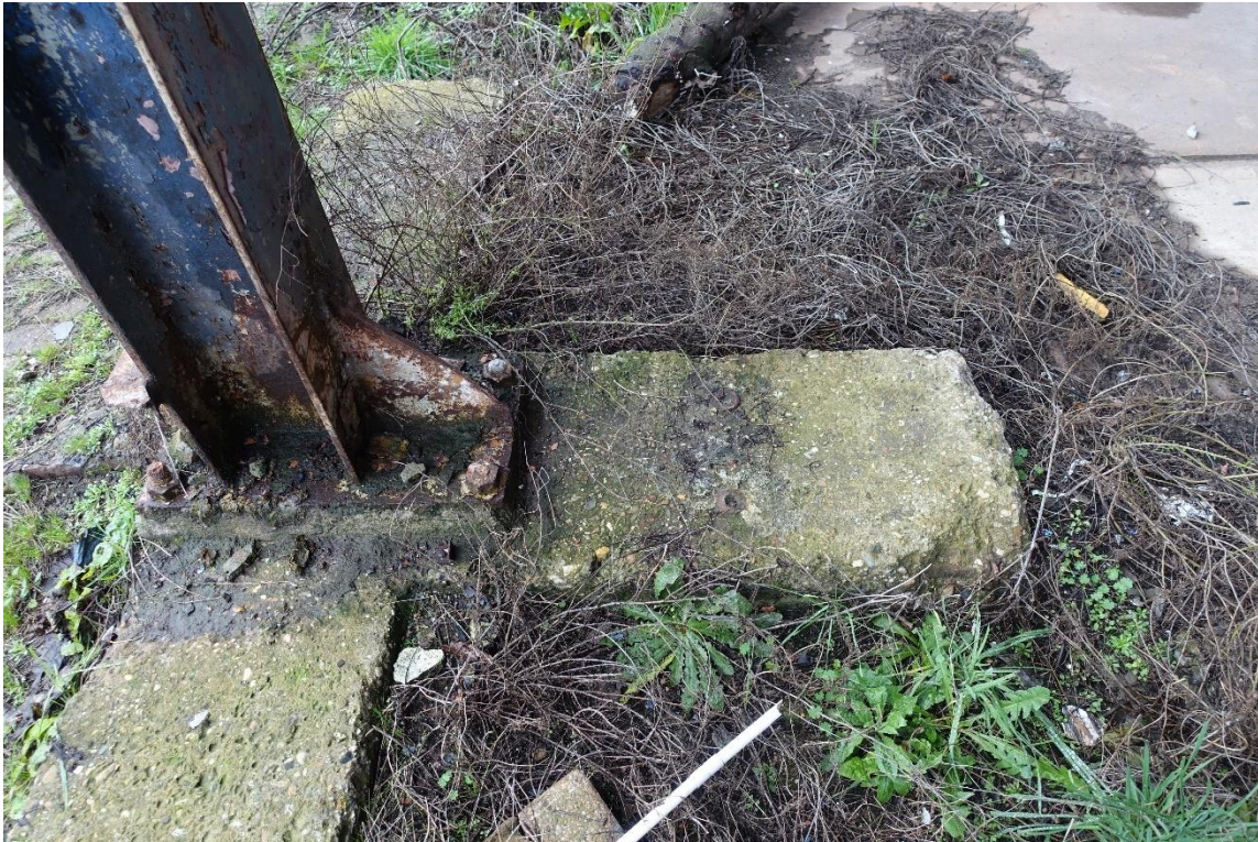
De fundatie van de stalen vollewandstijlen bestaat uit losse betonnen balken. De korte balk haaks op de lange diende om de stijlen van de kraanbaan te dragen.
