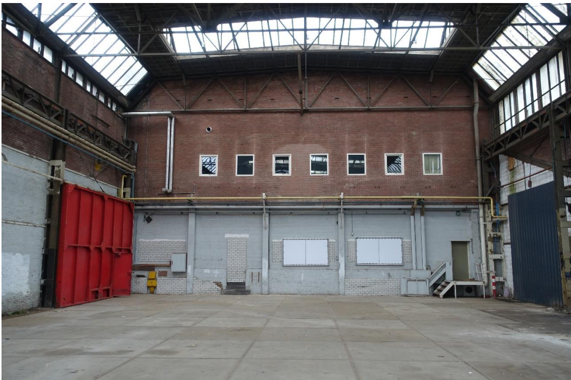
Tegen de gevel van het kantoor is de opbouw van de vakwerklijger in de oostelijk hal goed zichtbaar. De bovenste ligger is korter dan de onderste en is er met een diagonaal aan verbonden.
