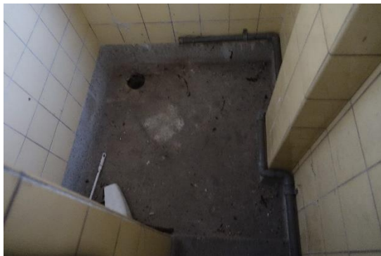
Een van de toiletten en de douche onder het trappenhuis aan de rechterzijde. De vloeren van granito met opstaande plint en de lichtgeel betegelde wanden passen uitstekend bij de bouw in 1950.
