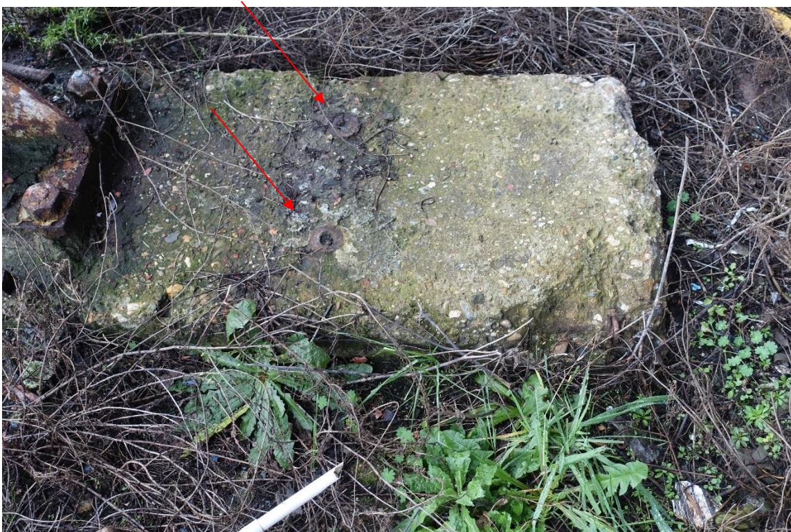
De twee ankers onder de voet van de kolom van de kraanbaan, deze zijn ook op de fundatie aan de westelijke zijde en in de westelijke hal zichtbaar.
