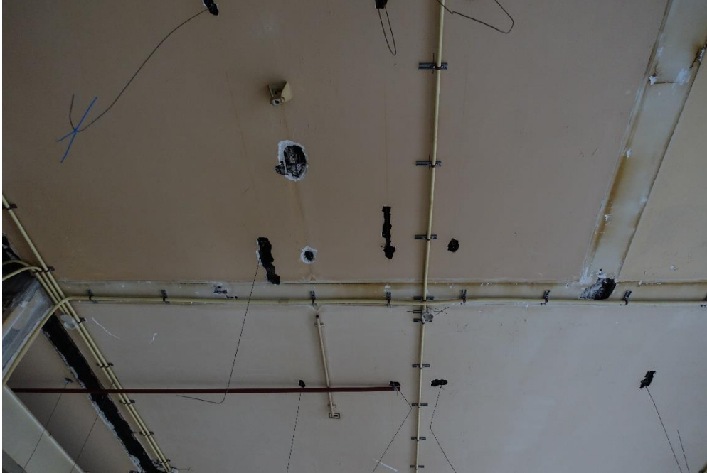
Een deel van plafond van de begane grond aan de rechter zijde.
