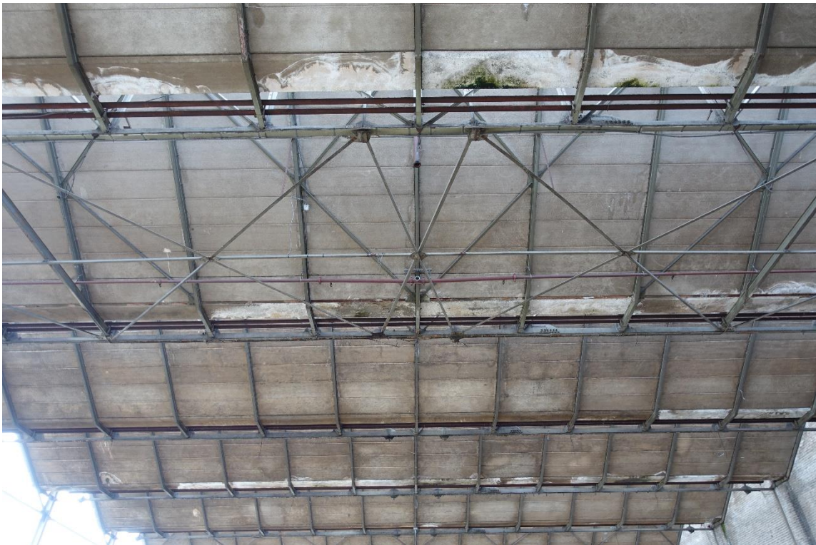
De opbouw van de kapconstructie. De vakwerkliggers hebben 12 vakken met dalende diagonalen. Elk vak heeft een ligger voor de Bimsbetonplaten.
