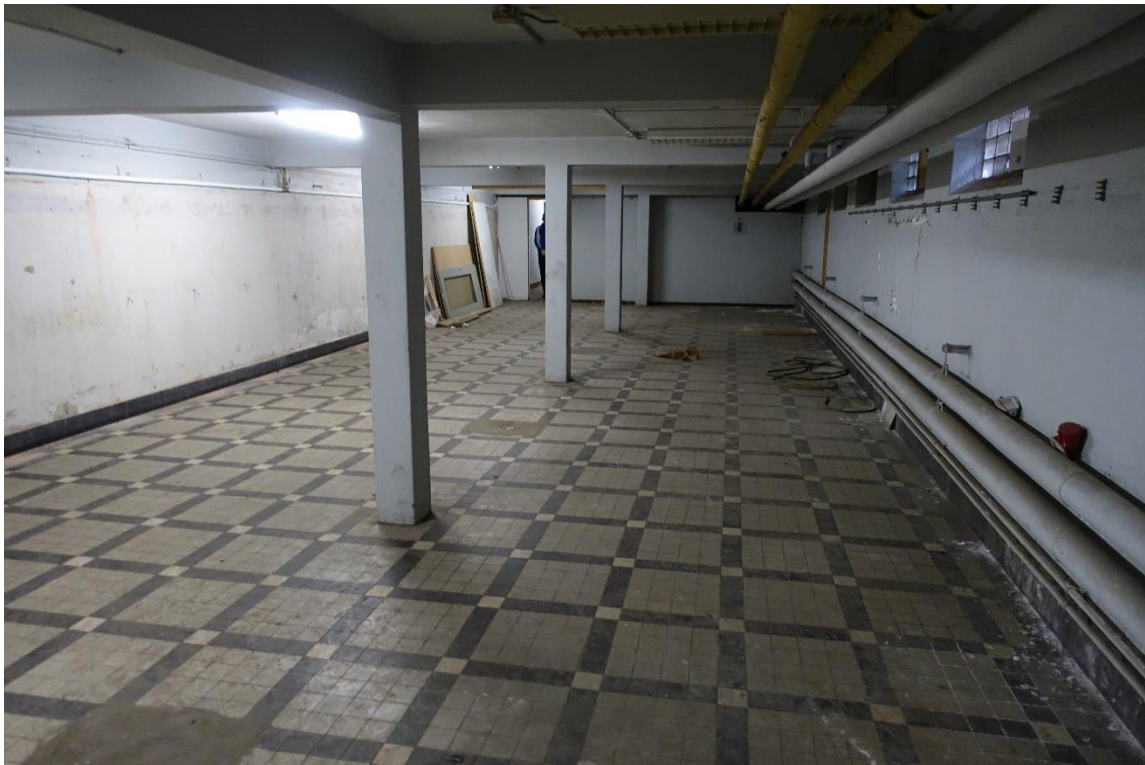
De wasruimte in het oudste deel van het kantoor. In de ruimte ondersteunen de pijlers de begane grond vloer, de gemetselde muur aan de linkerzijde ondersteunt de vloer in het midden.
