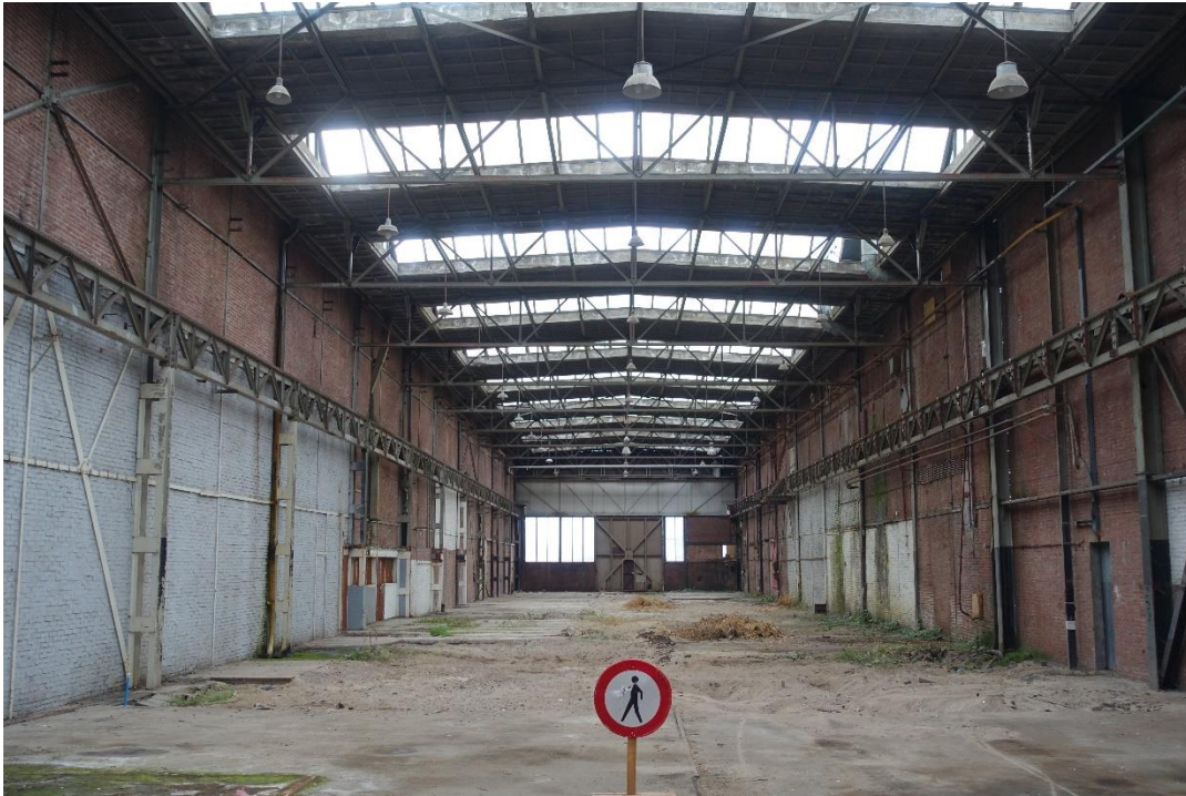
De westelijke halm gezien naar de haven. De vakwerkliggers hebben een rechte onderzijde en een licht hellende bovenzijde met het hoogste punt in het midden.
