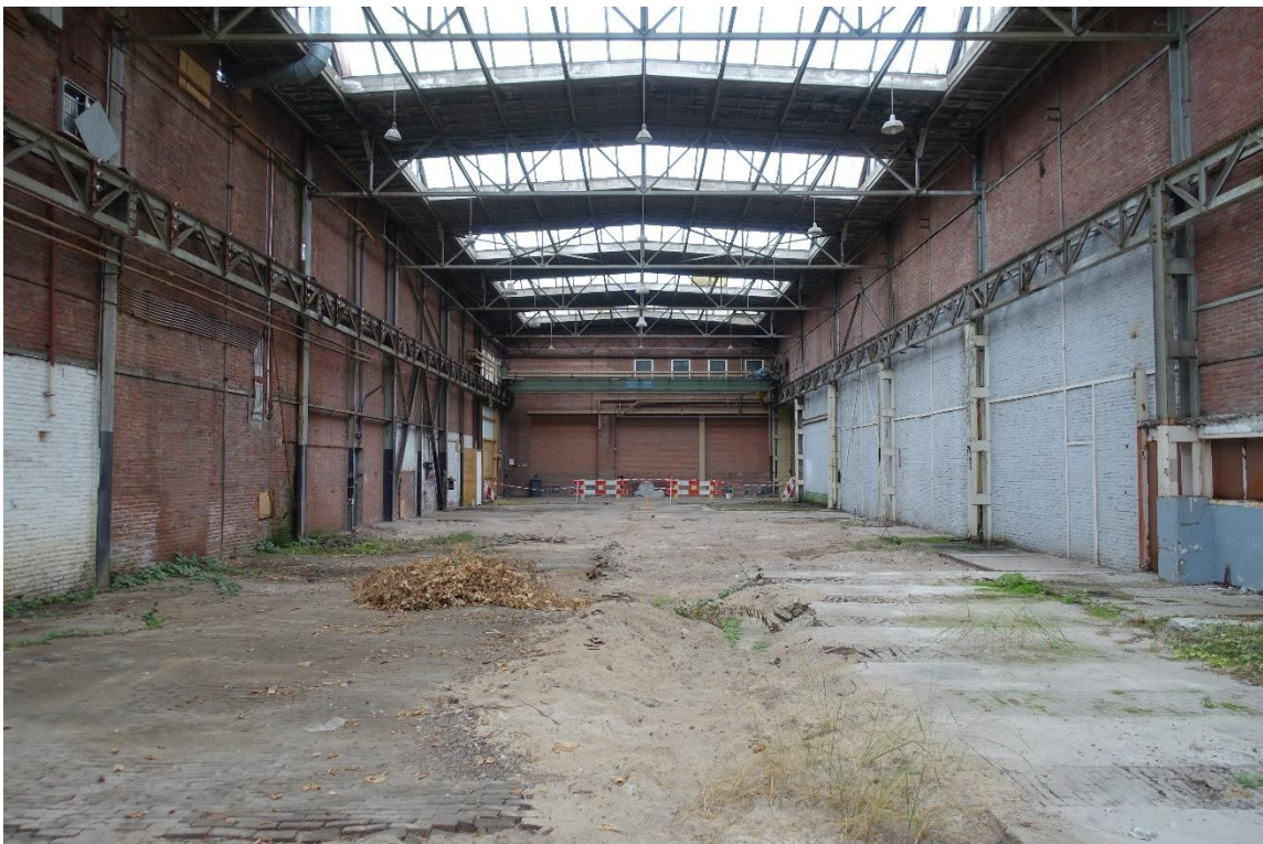
De westelijke hal heeft eveneens een vrij open dak door de lichtrupsen. Aan de zijden is het echter geheel gesloten.
