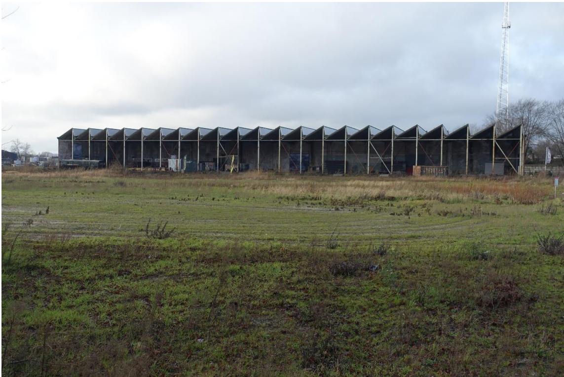
De oostelijke hal gezien vanaf het kantoor. De zaagtandconstructie van het dak is zeer karakteristiek en kenmerkend voor de industriële bebouwing. Ook de schaalgrootte van maar liefst 21 portalen past hierbij.
