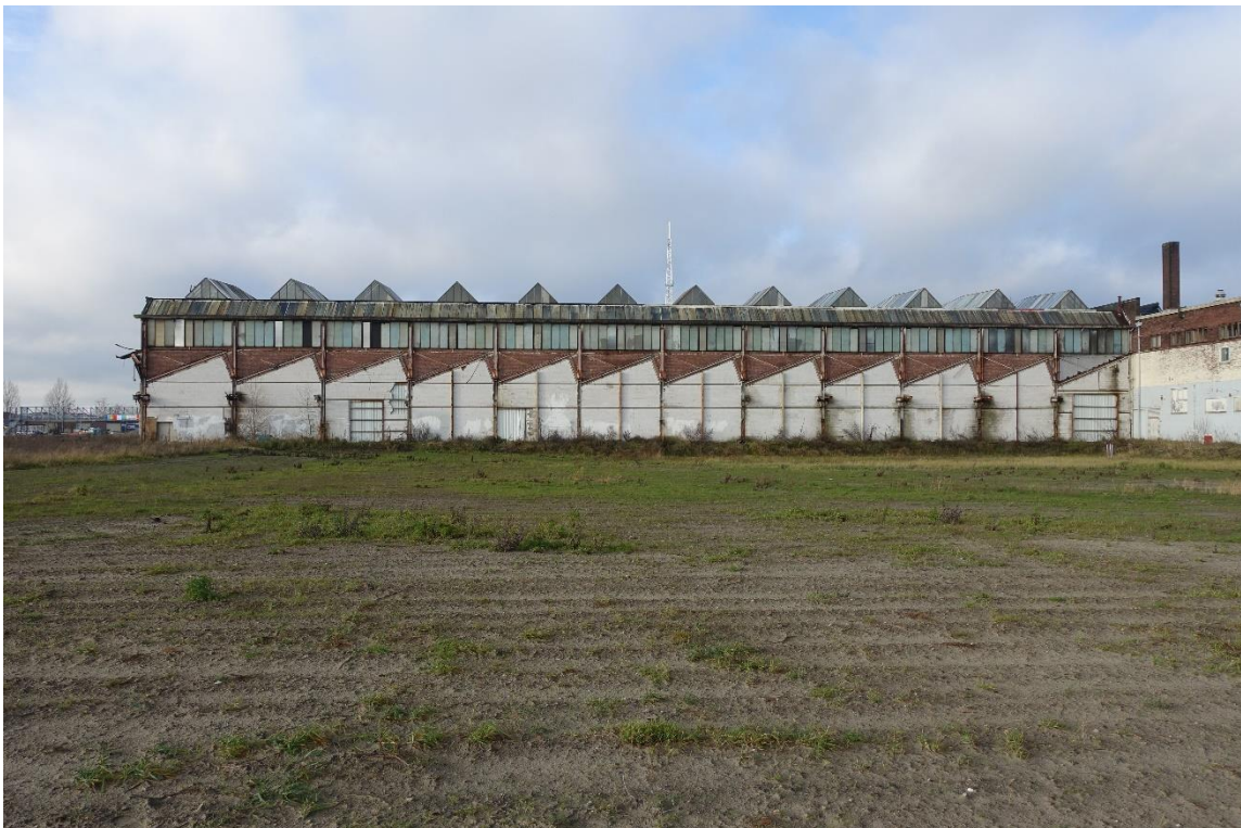
De buitengevel van de oostelijke hal. Duidelijk zichtbaar is dat de hal met de zaagtanddaken hier tegenaan stond. De witte delen onder de daklijn zijn recente, tijdelijke dichtzettingen.
