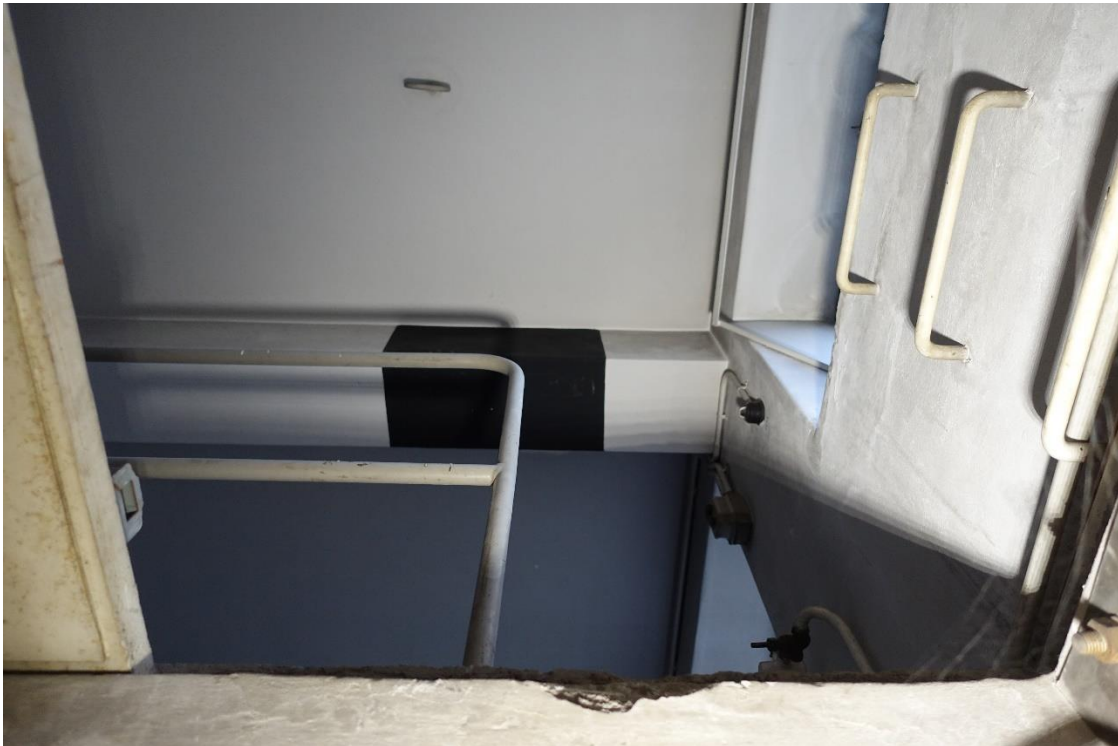
De treden in de wand om de machine kamer van de lift te bereiken. Deze ligt op een betonnen vloer.
