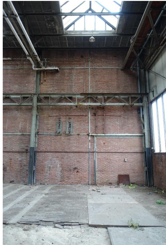
Links het windverband. Zowel langs de gevel als in het vlak onder de Bimsbetonplaten zijn er windverbanden aangebracht zodat er een geheel stijve travee ontstaat. Rechts de travee aan de zijde van de haven, de gevel staat direct tegen het laatste portaalspant.
