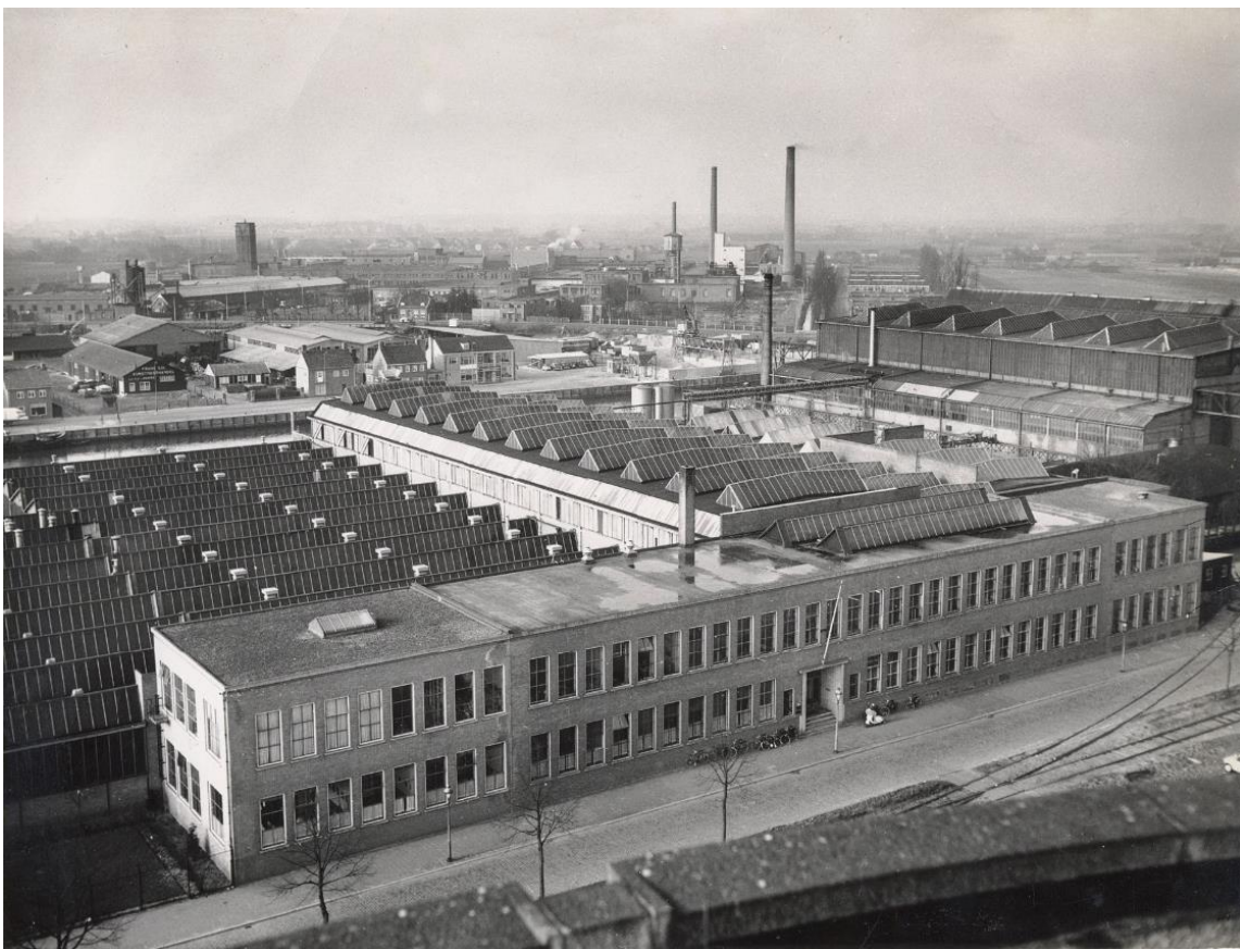
Foto uit 1959 met de voorgevel in de oorspronkelijke toestand. In de gevelopeningen staan de stalen venster nog. Op het dak zijn de lichtkappen rechts van de entree zichtbaar. Links hiervan de schoorsteen van de stookruimte. De linker uitbreiding is voorzien van een daklicht.
