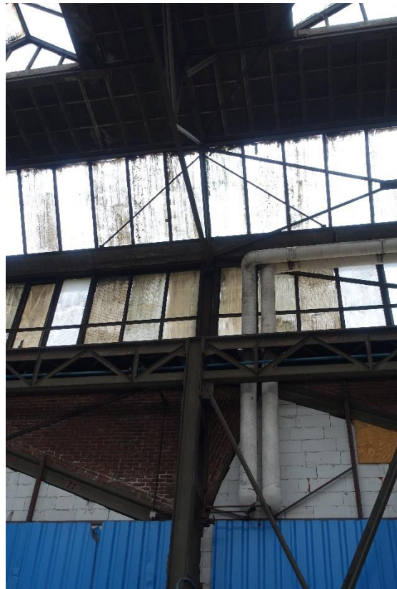
Links de lichtstraat met de windverbanden er voor en de schoren van de liggers. Rechts de lichtstraat in het dakvlak en op de oostelijke gevel.
