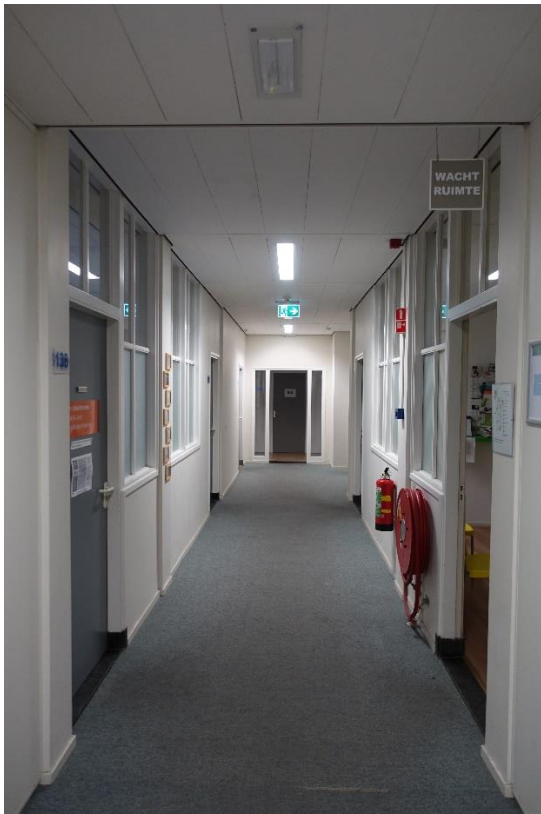
Links de gang in de uitbreiding van 1954. In tegenstelling tot de gang uit 1939 zijn hier puien geplaatst in plaats van gesloten wanden. Rechts één van de nieuwe pantry's. De tegels op de vloer zijn gelijk aan die van de toiletten op de verdieping.
