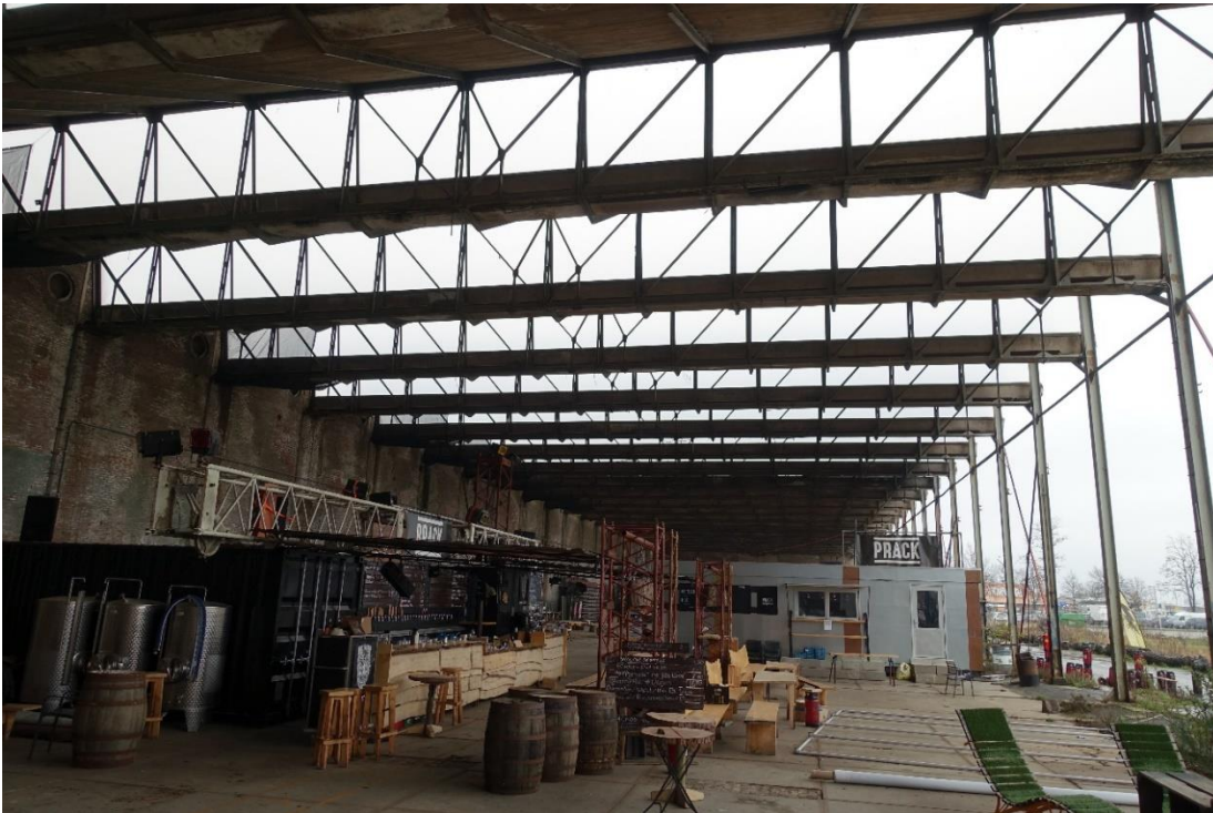
De portaalspanten gezien naar de voorgevel. De flauwe dakvlakken vallen in dit perspectief bijna weg.
