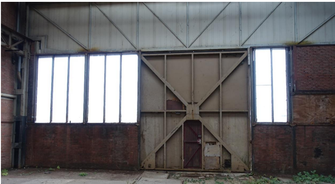
De oorspronkelijke stalen schuifdeur in de westelijke hal met in het midden een loopdeur.
