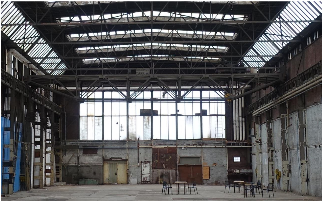
De binnenzijde van de achtergevel van de oostelijke hal. Afgezien van de ingebroken deuren is de gevel oorspronkelijk. Op de voorgrond de rolkraan.
