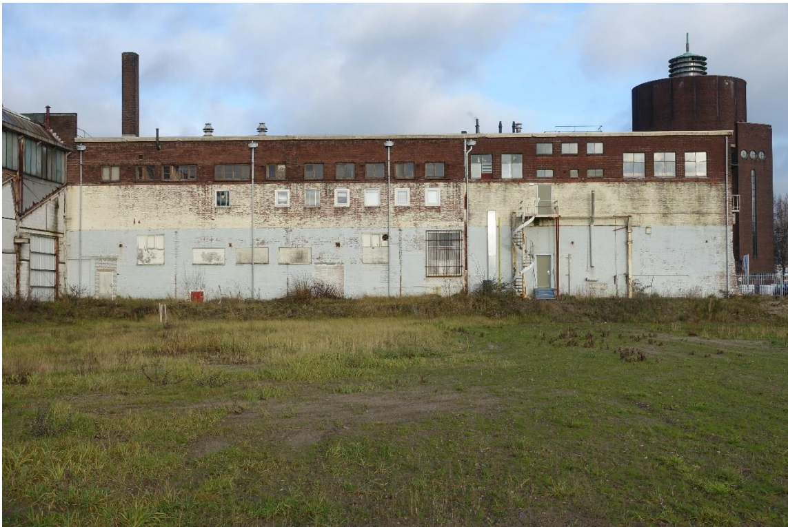
De rechterzijde van de achtergevel met geheel links de nog bestaande hal uit 1938.
