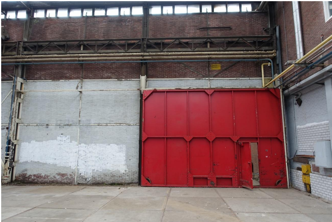
De inpandige deur tussen de twee hallen. De schuifdeur wordt zowel door de rail aan de bovenzijde als de wielen aan de onderzijde gedragen. In de deur is een loopdeur aangebracht. De deur is van staal, waarschijnlijk is deze in de fabriek zelf gemaakt.
