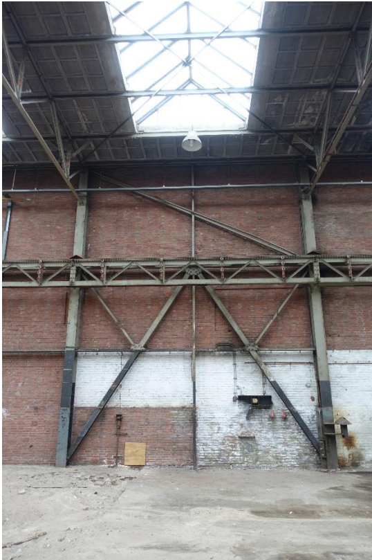
Links het windverband. Zowel langs de gevel als in het vlak onder de Bimsbetonplaten zijn er windverbanden aangebracht zodat er een geheel stijve travee ontstaat. Rechts de travee aan de zijde van de haven, de gevel staat direct tegen het laatste portaalspant.
