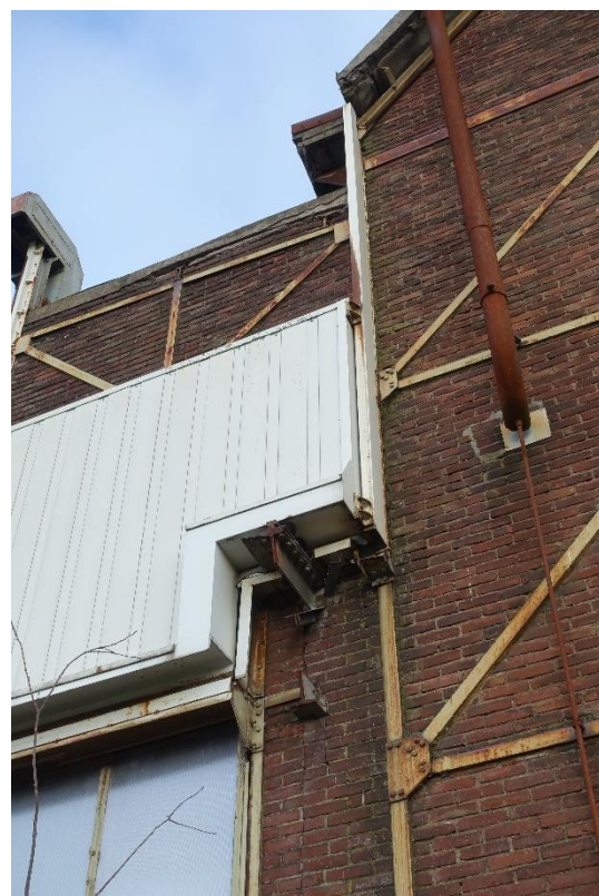
Beide foto's laten de afgebrande einden van de rolbaan zien. Het witte paneel kon via de heftorens worden opgetild zodat de rolkraan naar buiten kon. Op de opening het oorspronkelijke metselwerk met stalen stijlen en schoren.
