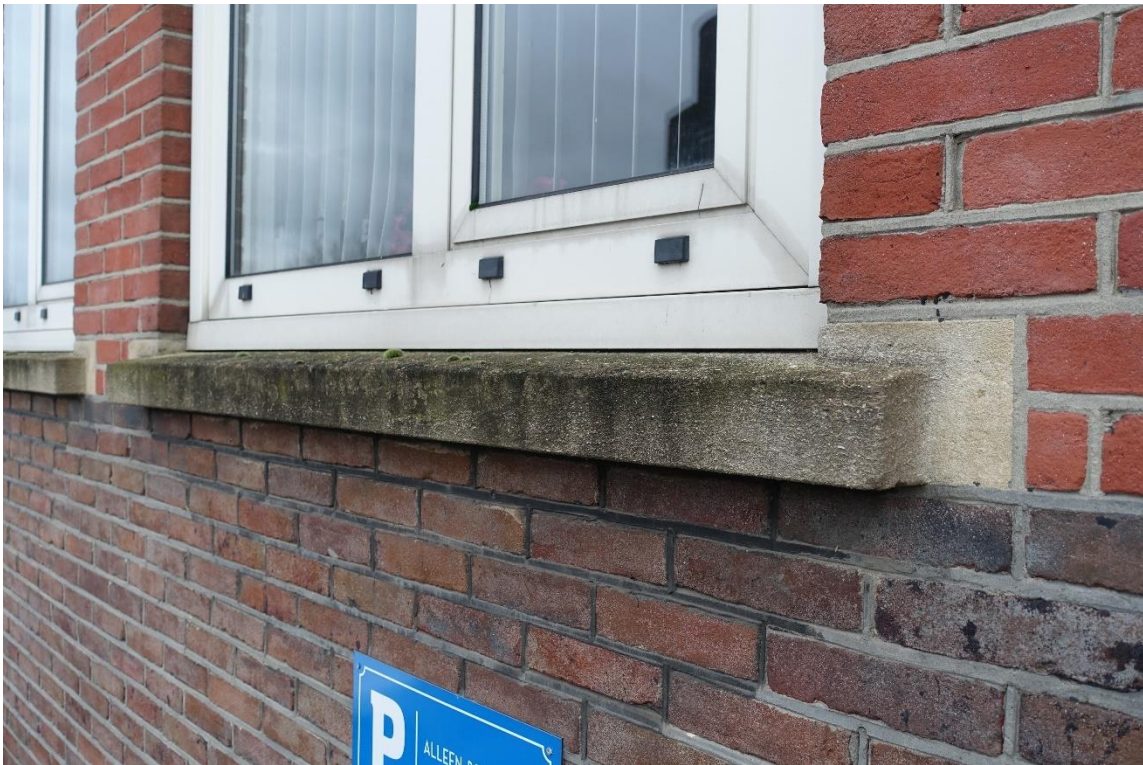
De kalkstenen dorpels onder de kozijnen met eronder het metselwerk van de plint. Eronder lijkt nog een deel van het oorspronkelijke donkere voegwerk aanwezig.
