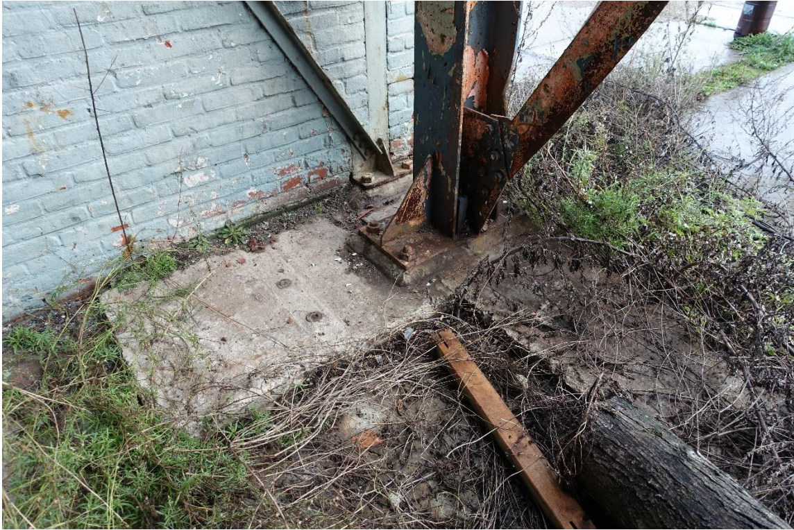
De fundatie ter plaatse van de voorgevel. De stalen vollewandstijl die de vakwerkligger draagt staat aan de binnenzijde van de gevel. De gevel zelf bestaat uit metselwerk tussen stalen stijlen. De fundatie hiervan is niet zichtbaar, deze zal dieper onder het maaiveld zijn aangebracht.
