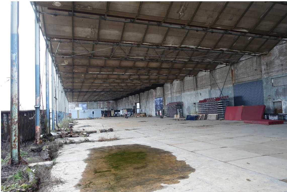
De oostelijke hal gezien richting de haven. Aan de oostelijke zijde had de hal geen gevel, deze werd gevormd door de gevel van de reeds bestaande hallen aan die zijde.
