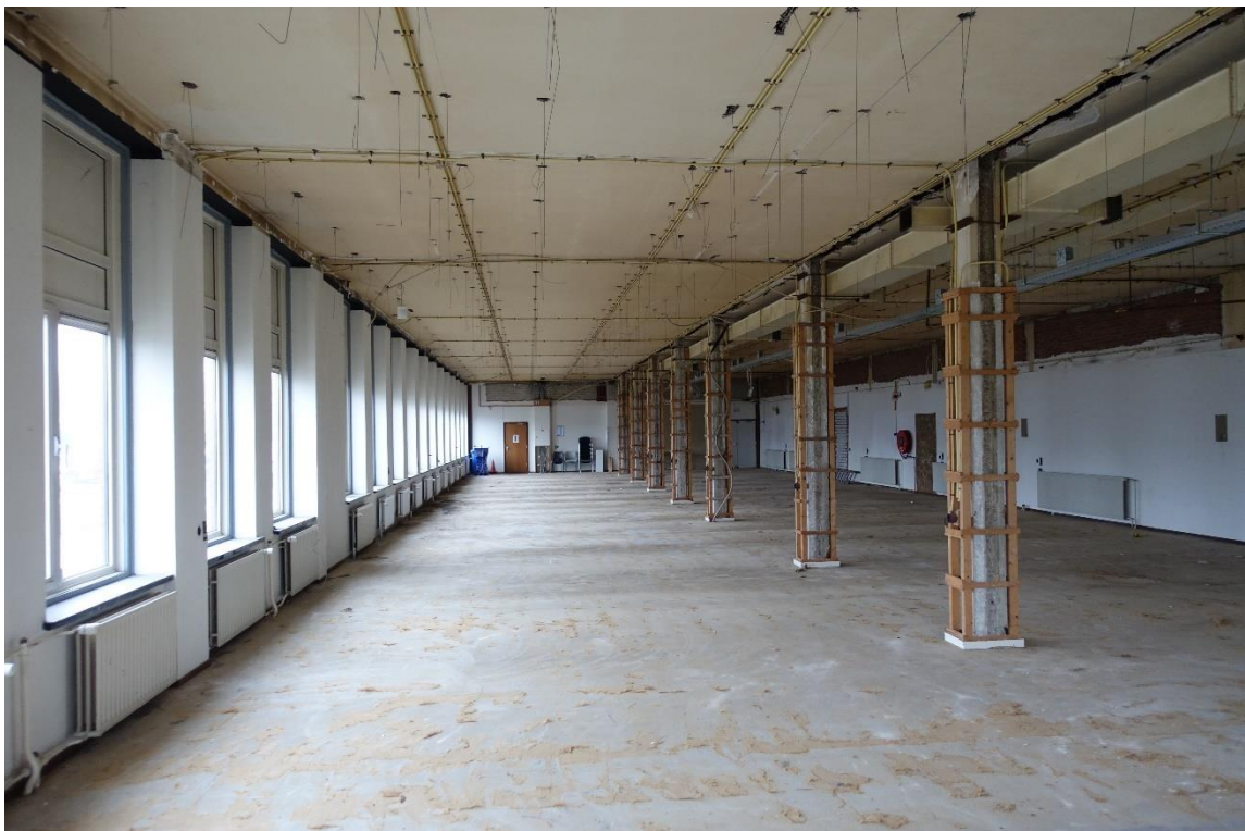
De rechterzijde van de begane grond. De verdieping wordt gedragen door de pijlers in het midden. Op de plafonds tekenen de scheidingswanden zich nog af.
