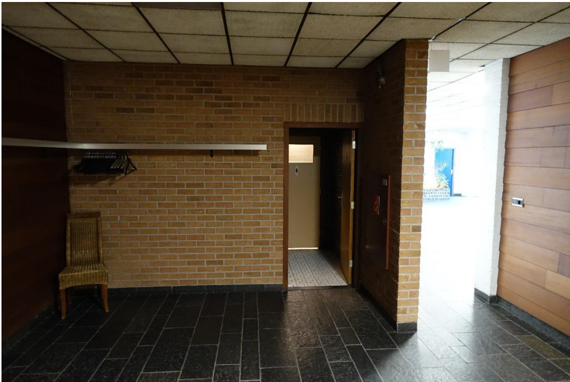
De garderobe met rechts de verbinding naar de hal. Links de toegang tot de damestoiletten, de herentoiletten liggen hier tegenover. Het schoon metselwerk is gelijk aan dat van het trappenhuis, net als de betegeling van de vloer. De red-cedar lambrisering is oorspronkelijk volgens de tekening.
