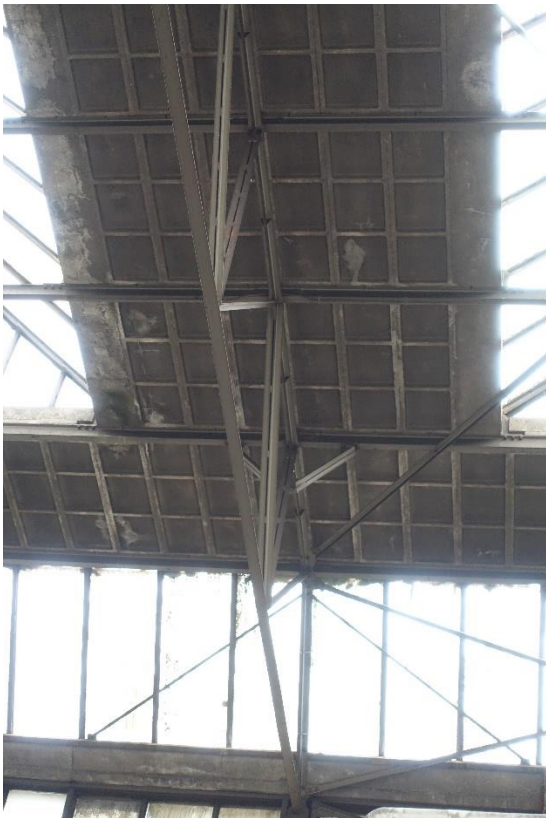
Links de lichtstraat met de windverbanden er voor en de schoren van de liggers. Rechts de lichtstraat in het dakvlak en op de oostelijke gevel.
