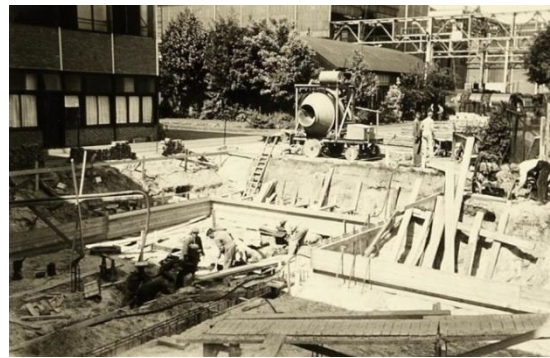
Foto's uit 1950 van de aanbouw van het kantoor. Fundatie en keldervloer.
