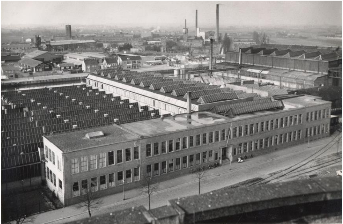
Het kantoorgebouw met de uitbreidingen aan beide zijden en de achtergelegen fabriekshal in 1959 gefotografeerd (vanaf de watertoren).
