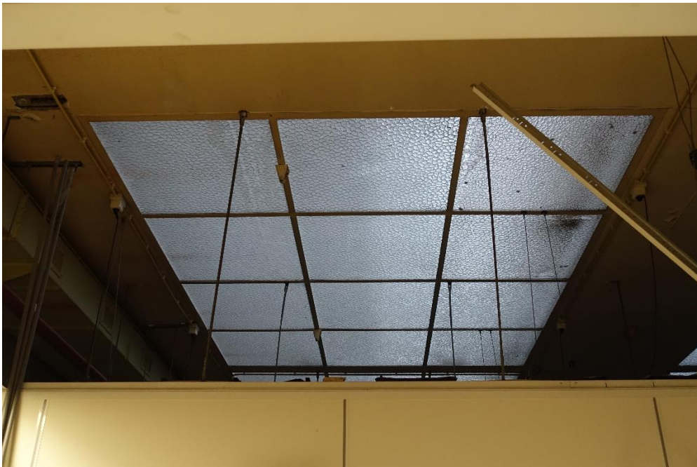
Eén van de twee daklichten onder de lichtkappen. De roedes zijn van metaal, het glas is uit 1939.
