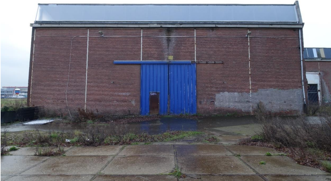
De voorgevel van de oostelijke hal. De deuropening is oorspronkelijk, de deuren zelf niet.
