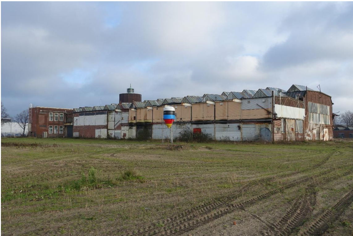
De beide hallen gezien vanaf de haven. De constructie van het dak met de lichterupsen is zeer karakteristiek en kenmerkend voor de industriële bebouwing. Ook de schaalgrootte van 12 traveeën past hierbij.
