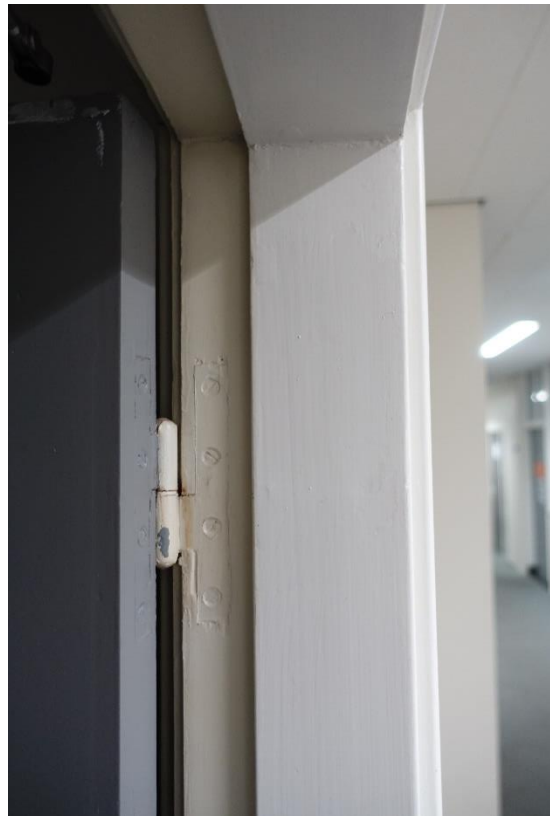
Links één van de oorspronkelijke deuren met aan de linkerkzijde de paumelle scharnieren. Rechts de scharnieren met bevestiging aan deur en kozijn.
