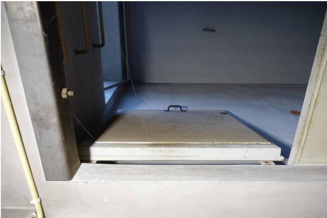
Het luik naar de machinekamer van de lift in de linker aanbouw.
