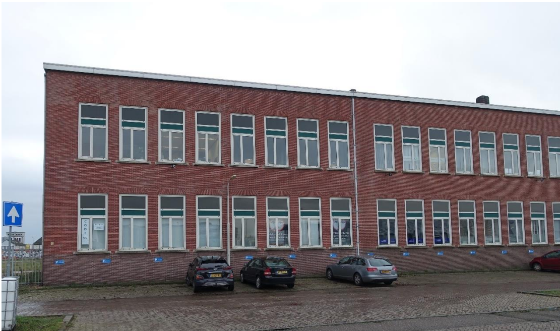
De linkerzijde van de gevel. Ter plaatse van de hemelwaterafvoer is de scheiding van het werk uit 1939 en de uitbreiding van 1954. In het metselwerk is geen verschil waarneembaar.
