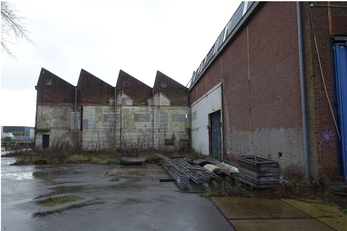
De voorgevel van de westelijke hal en de eerste vier traveeën van de oostelijke hal. De witte delen van de gevels laten zien waar er latere aanbouwen hebben gestaan, deze zijn recent gesloopt. De openingen in de gevel zijn dichtgezet.
