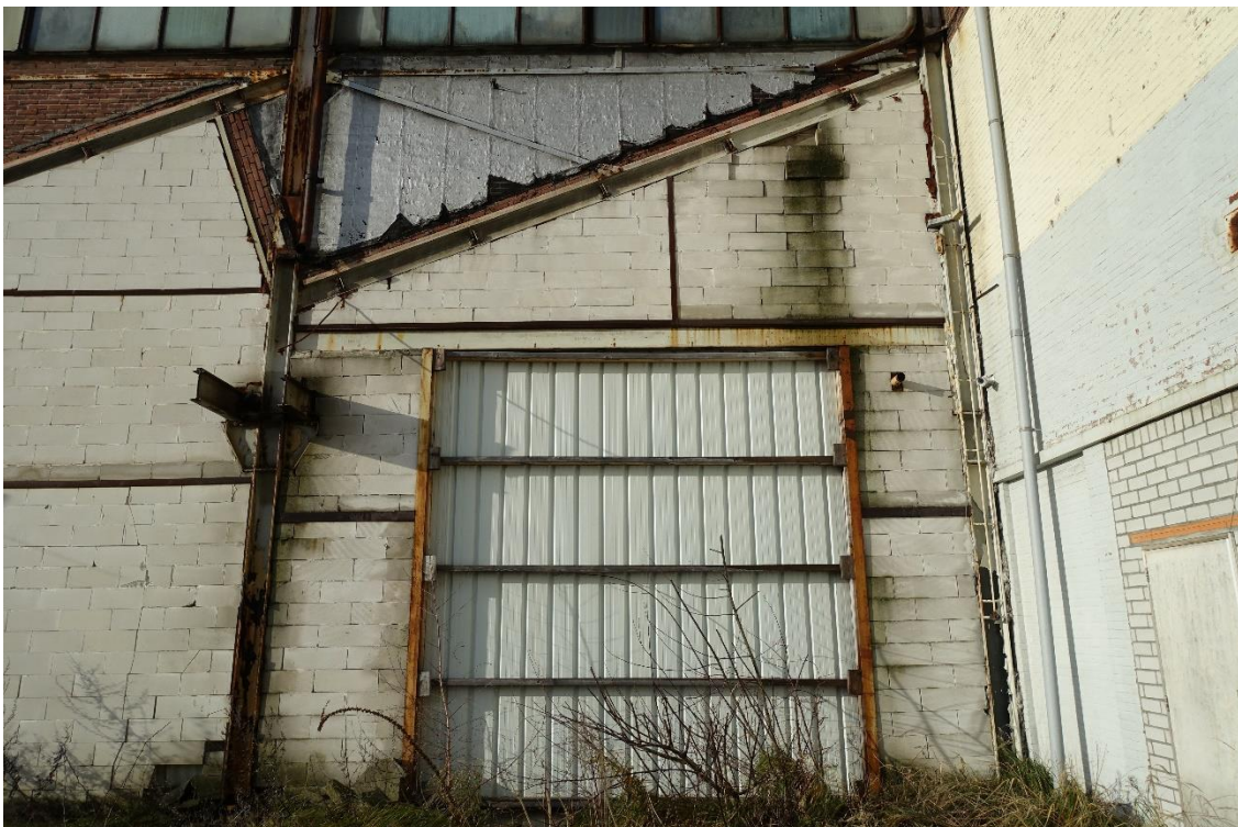
De dichtgezette deuropening in de eerste travee. De deur staat onder een stalen ligger die oorspronkelijk is. De stalen liggers van de zaagtanddaken zijn met bouten aan de stijlen vastgezet. De stalen schoren zijn met bouten vastgezet, de fles is aan de stijl gelast.
