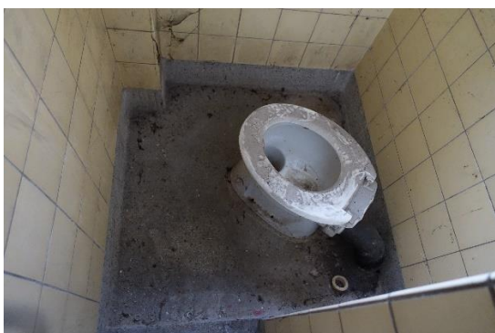
Een van de toiletten en de douche onder het trappenhuis aan de rechterzijde. De vloeren van granito met opstaande plint en de lichtgeel betegelde wanden passen uitstekend bij de bouw in 1950.
