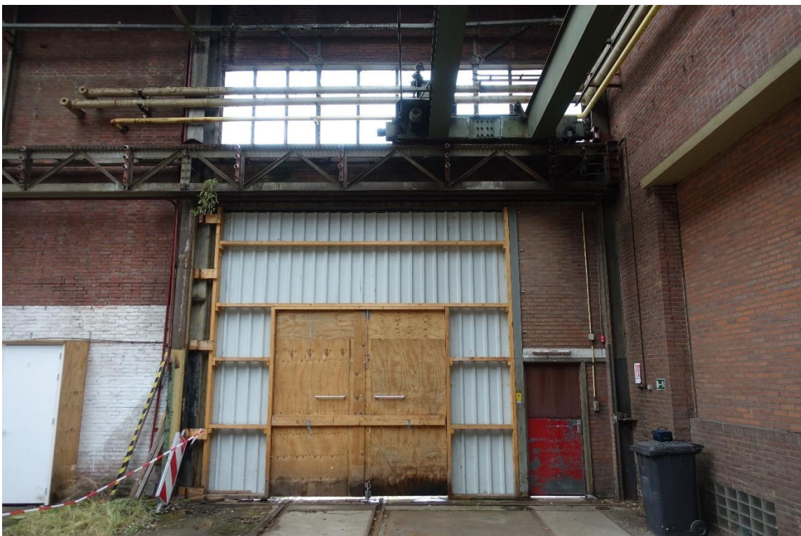
De binnenzijde van de eerste travee. Boven de deuropening de vensters. De deuropening is tijdelijk dichtgezet. Onder de houten deuren het smalspoor.
