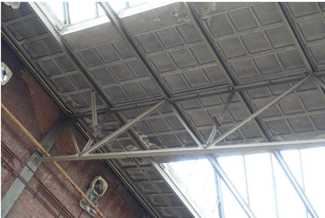
Het begin van de ligger met twee V diagonalen. Elk I-profiel waarop de Bimsbetonplaten liggen wordt ondersteund door of de bovenzijde van de V of een verticale stijl.
