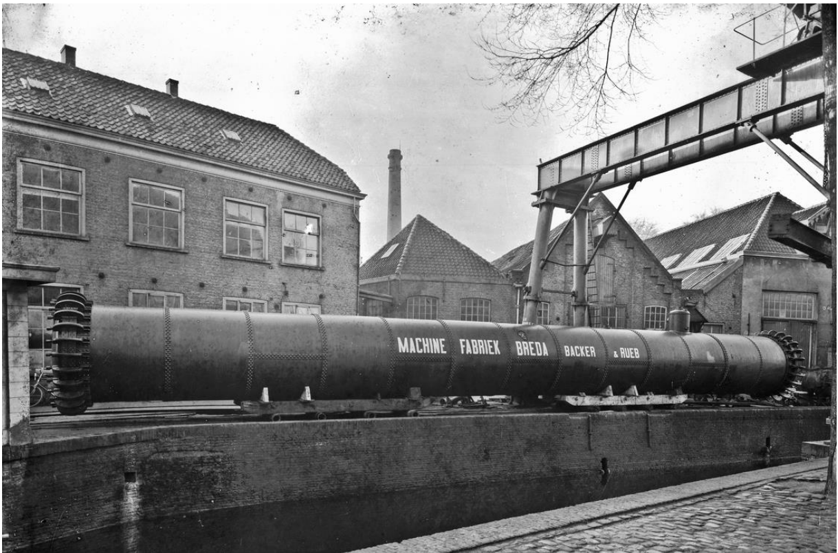
De gebouwen op de luchtfoto zijn op deze opname van straatniveau te zien, kijkend over de stadsgracht. De fotograaf staat iets ten oosten van het van het huidige Franciscanessenplein.
