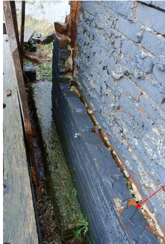
Links zicht op de opbouw van het metselwerk in de stijlen, beide bladen vielen tegen de flens. Rechts de hoek waar de stenen bekapt zijn om de stijl heen. Bij de pijl een spouwhaak.
