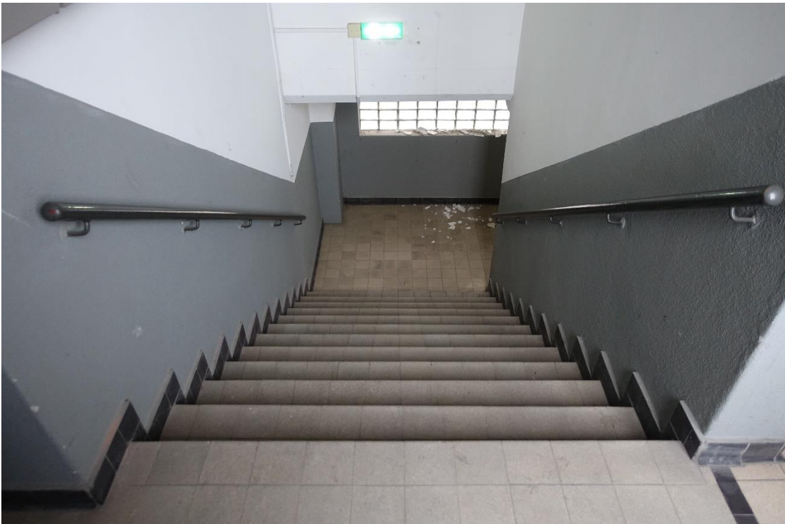
De trap aan de rechterzijde van de verdieping naar de achtergevel gezien. De situatie is geheel oorspronkelijk.
