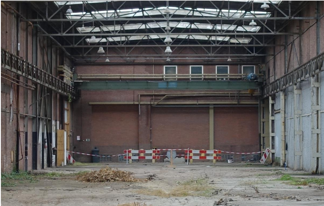
De gevel van het kantoor in de westelijke hal. Voor de gevel de kraan van de hal.
