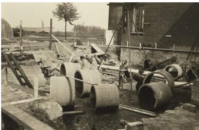
De opbouw van de fundatie op de doorsnede van de uitbreiding van 1954. De lift in de uitbreiding is zwaarder gefundeerd.
