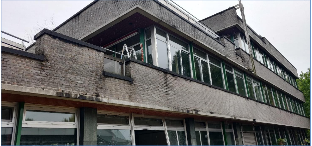
Foto 04: het pand met de stenen wanden met de open stootvoegen.
