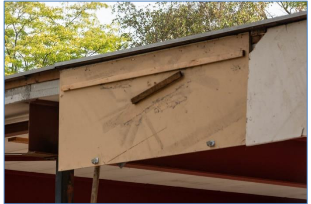
Foto 06: bij de panden met boeiboorden zijn de platen waar de paarverblijven zaten, bewaard gebleven en zijn de aansluitende platen verwijderd.
