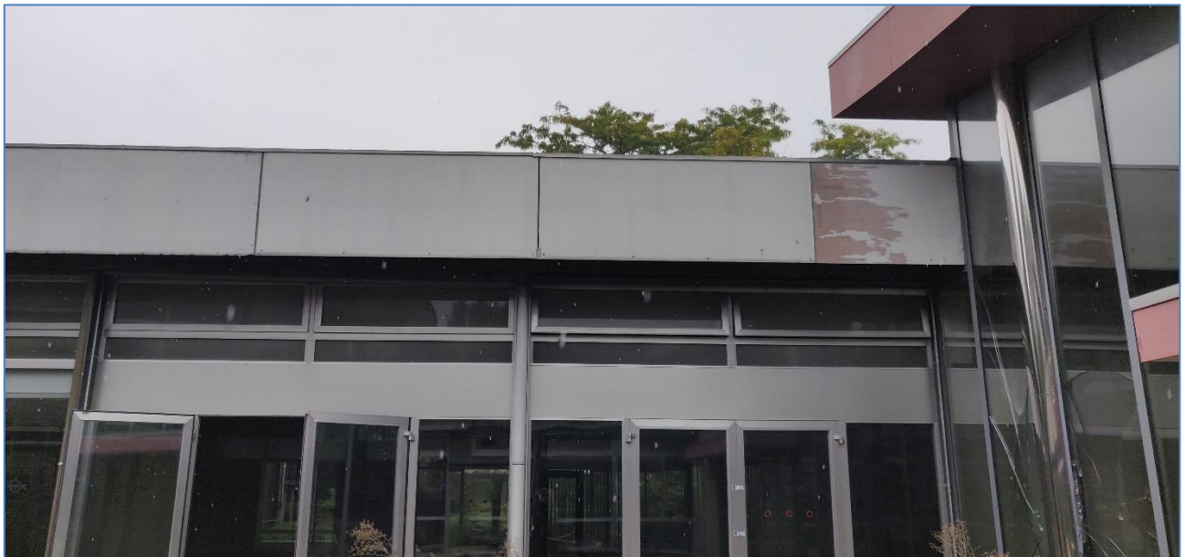
Foto 03: boeiboorden zullen verwijderd worden, behalve op die plaatsen waar een verblijf is aangetroffen.
