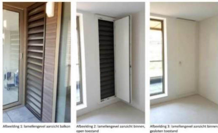
Figuur 11: Principe geluidwerend louvre aan de binnenzijde afsluitbaar
