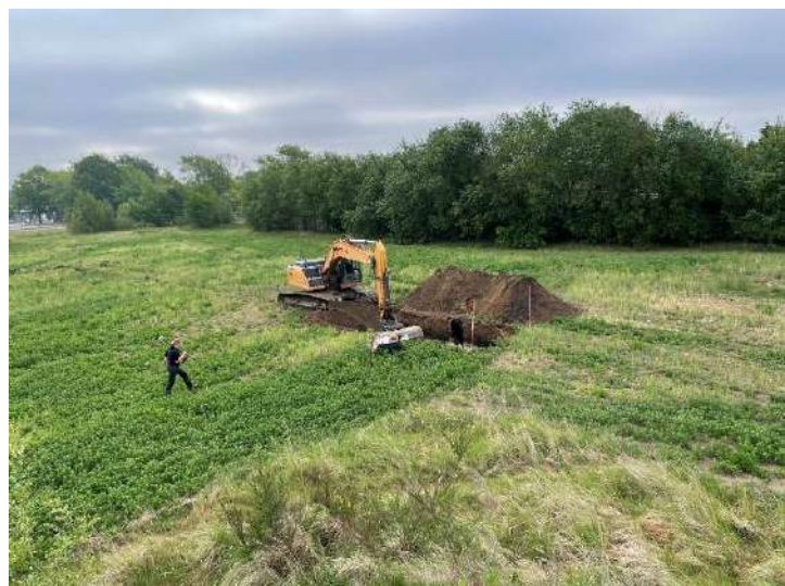
Fig. 4.2. Breda-Hero West. Impressie van de veldwerkzaamheden.
