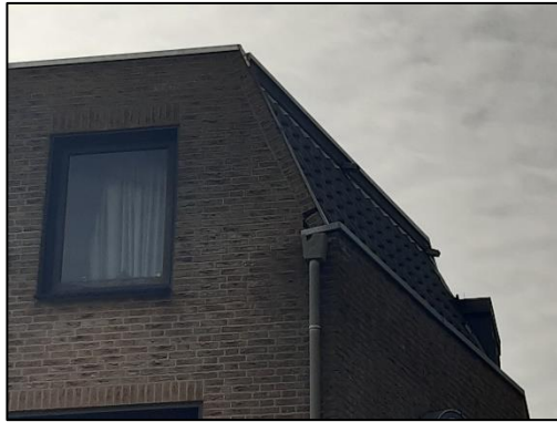
Figuur 4.3. Kieren langs de dakrand, die toegang geven tot het gebouw.
