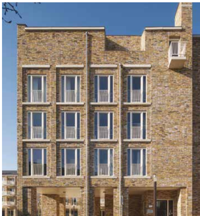
Rustige vorm en raamritmiek
