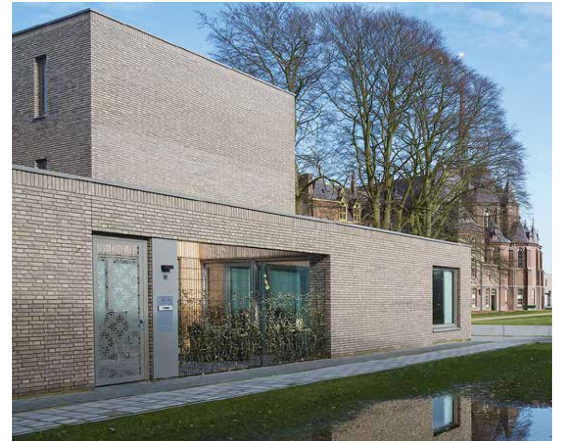
Terugspringende bovenbouw en een doorlopende plint rondom het blok
