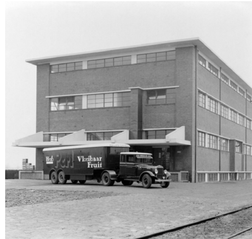
Historisch Hero, karakteristieke bandramen en betondetails
