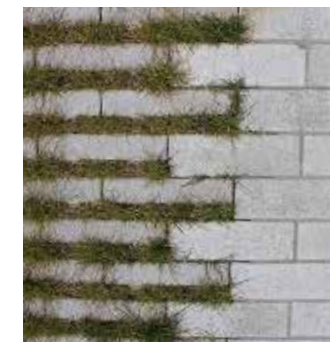
Haaks parkeren aan buitenzijde profiel voor bezoekers en bewoners van de appartementen. Parkeervakken met uitstapstrook: Hydro lineo grasbetonsteen
