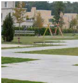
Grote betonnen elementenverharding
