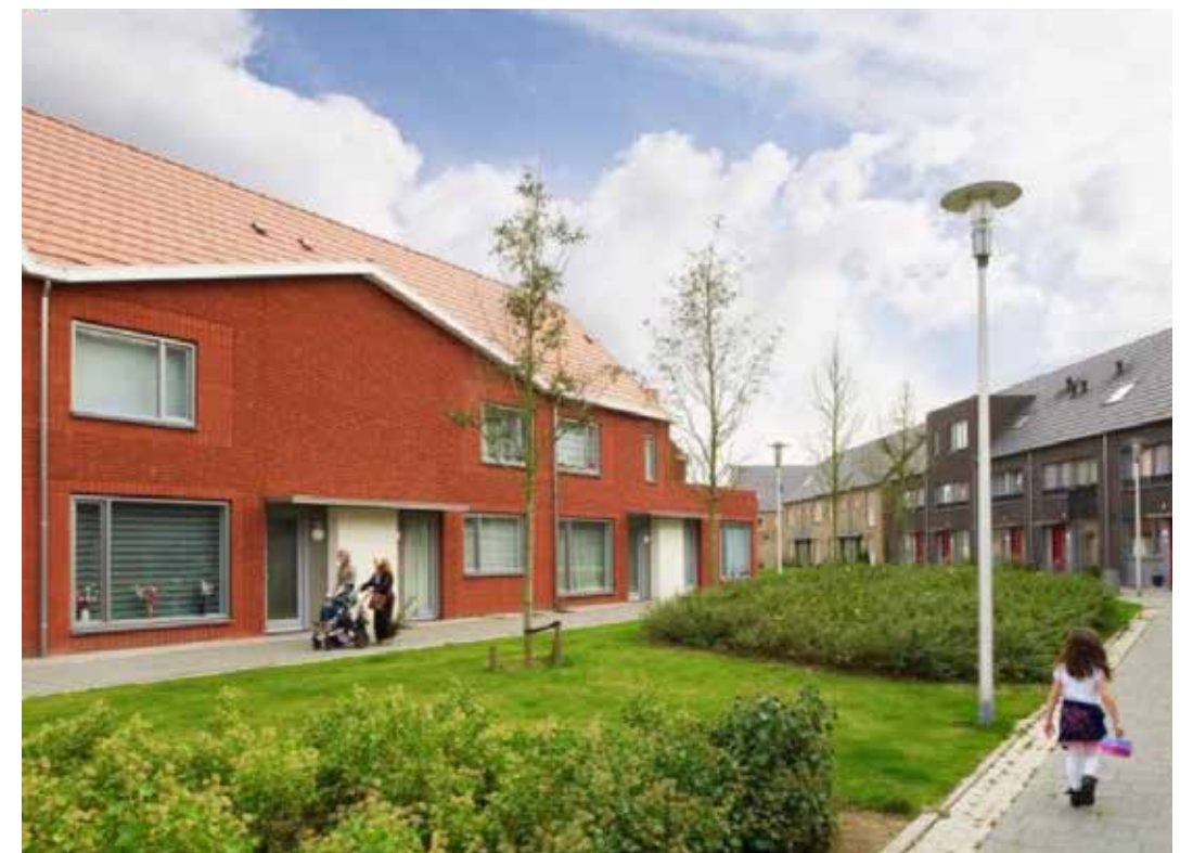
Gootlijn beëindigd en volgt gevelvlak met verschillende hoogten
