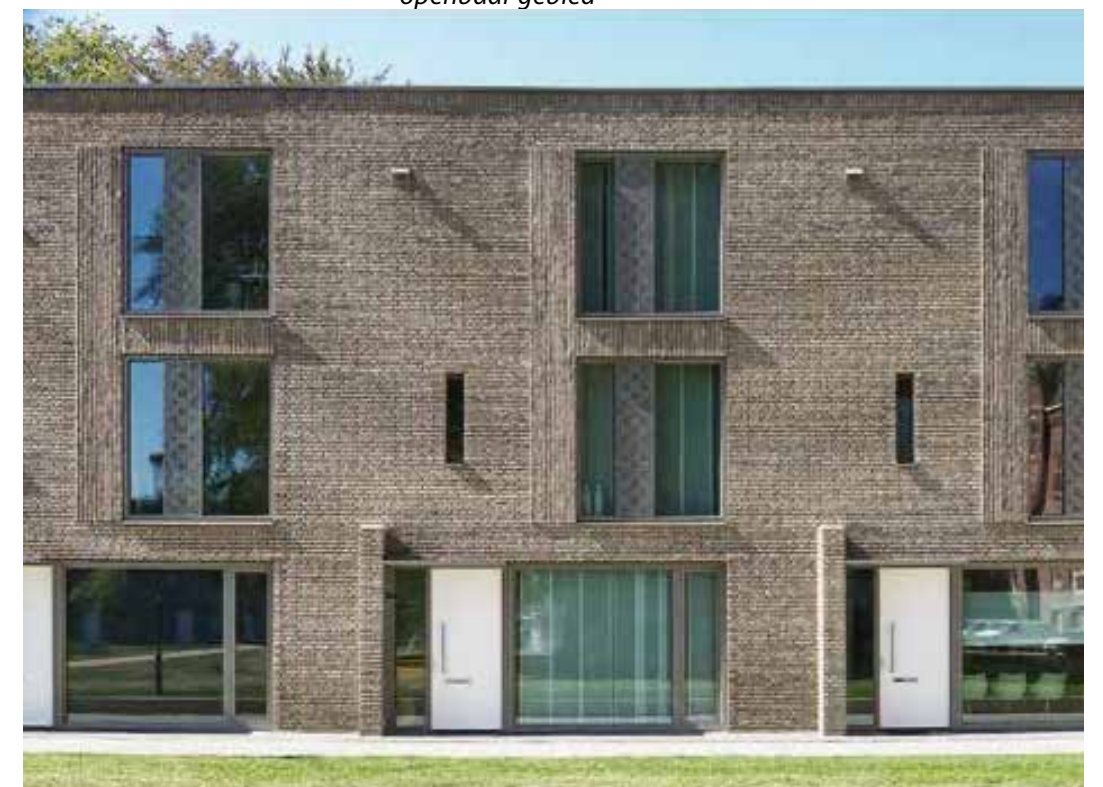
De begane grond gevel onderscheidt zich van de gevel van de verdiepingen
