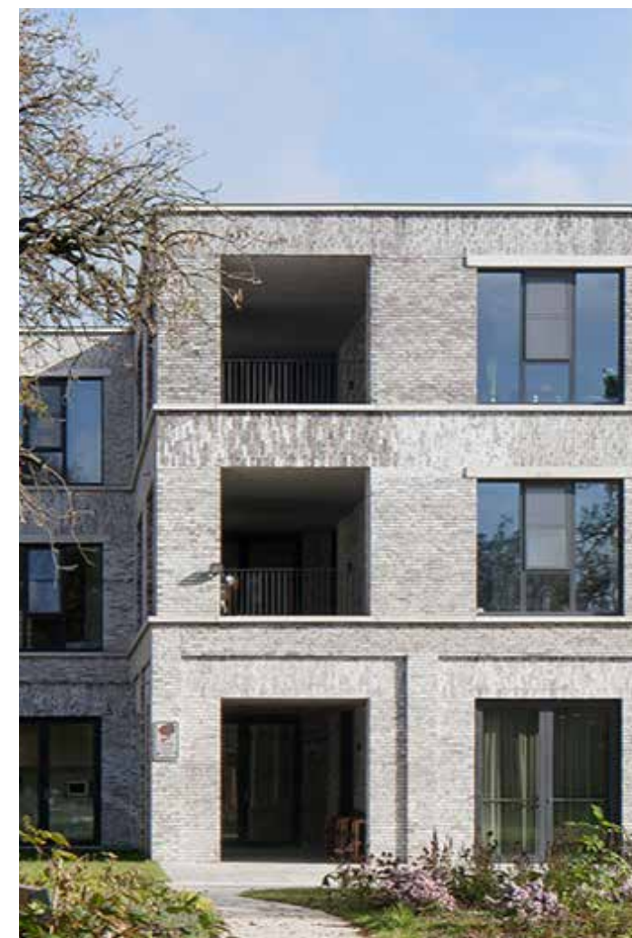
Rustig grid van gevelopeningen
