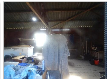
Foto 21: Houten schuur (interieur).
