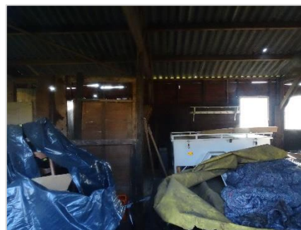
Foto 20: Houten schuur (interieur).
