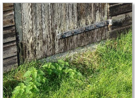
Foto 12: Houten schuur (geen openingen bij deuren).
