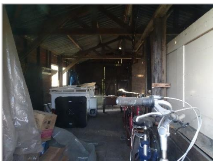
Foto 19: Houten schuur (interieur).
