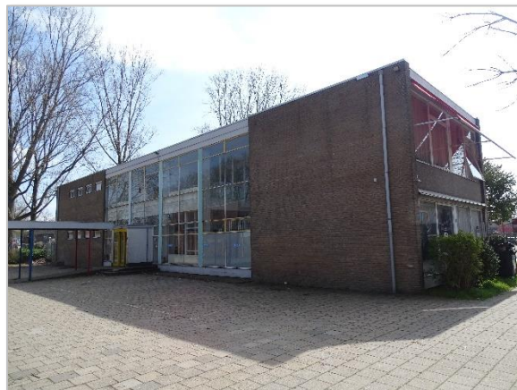
Foto 2: Impressie ligging plangebied Namenstraat 62 te Breda (voormalig schoolgebouw – achterzijde).
