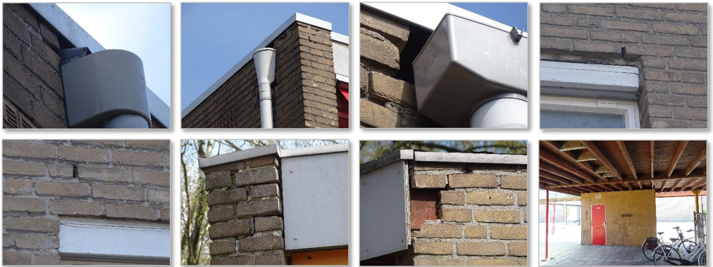
Foto 18 t/m 25: Mogelijke toegangsplaatsen vleermuizen tot spouwmuur en mogelijke verblijfplaatsen vleermuizen in fietsenstalling en corridor.
