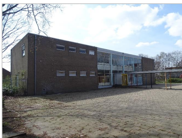
Foto 11: Impressie ligging plangebied Namenstraat 62 te Breda (voormalig schoolgebouw – achterzijde).
