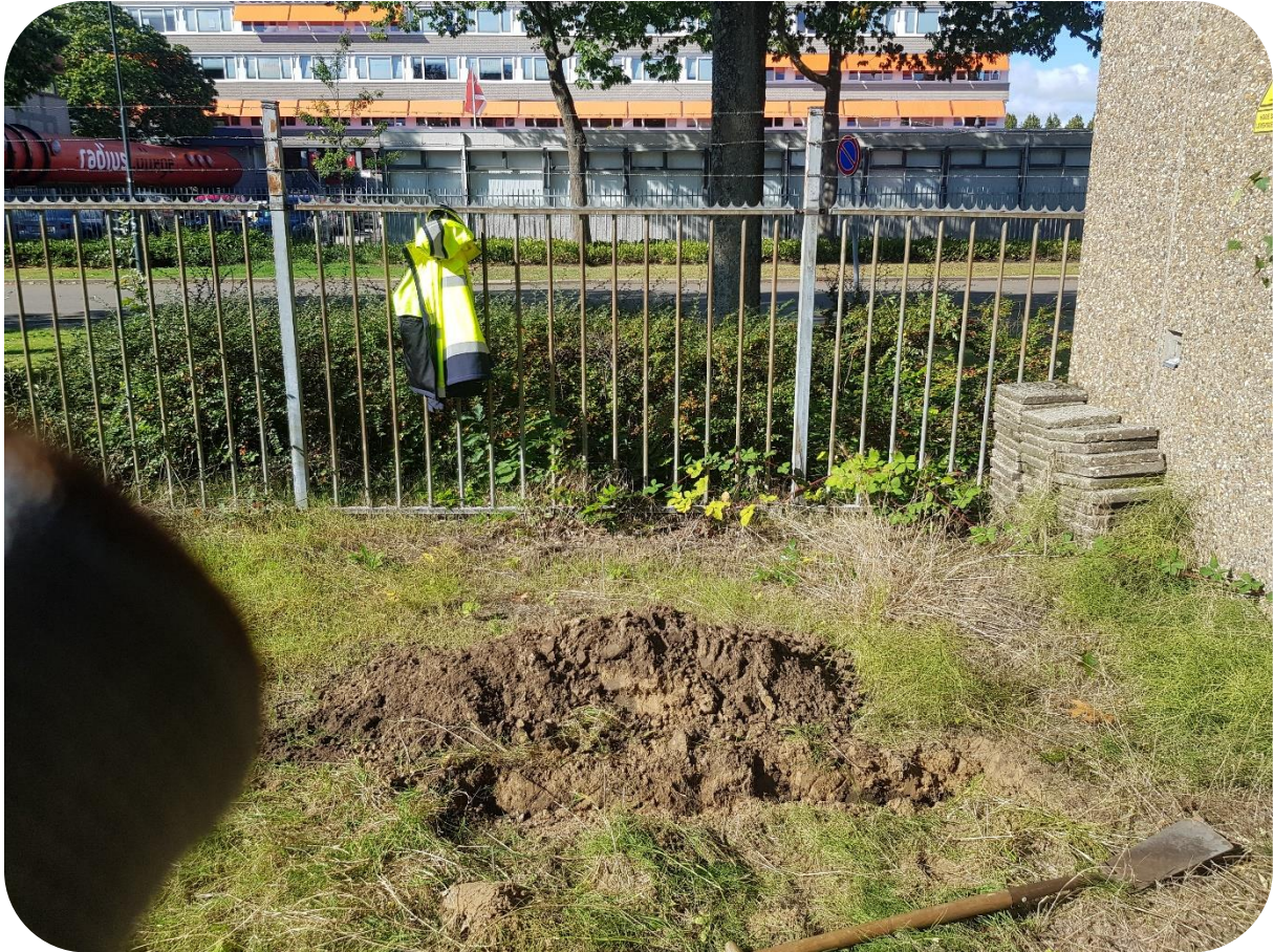
Foto 15: proefsleuf nabij boom 4 (oostzijde, op circa 4,5 meter)
