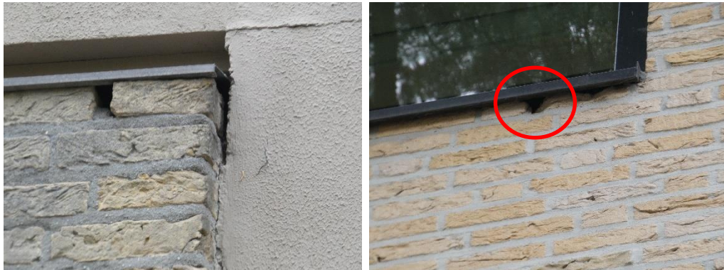
Figuur 4.3. Geschikte inkruipopeningen voor vleermuizen aan oostgevel schoolgebouw.
