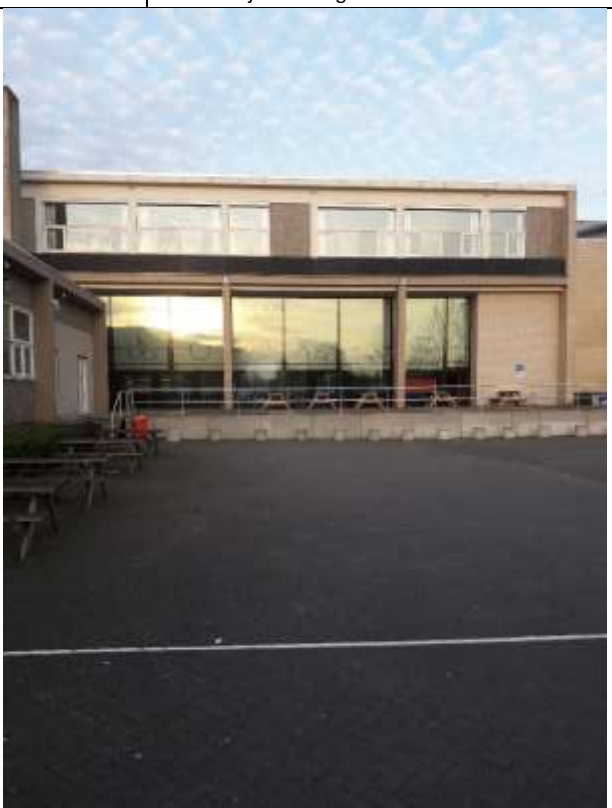
Fotonummer: 3: Schoolplein achter schoolgebouw
