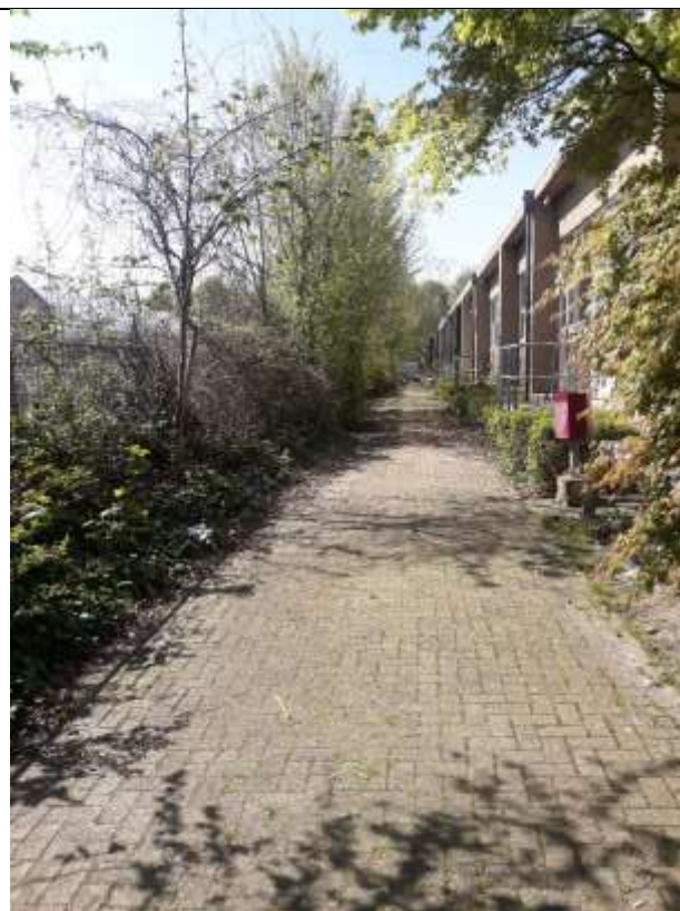
Fotonummer: 2: Zuidzijde schoolgebouw
