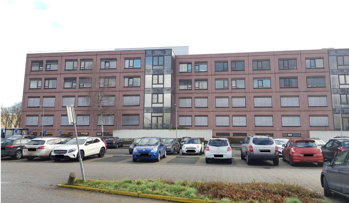
Figuur 1: Hoofdgebouw ziekenhuis met parkeerplaats gezien vanuit westen
