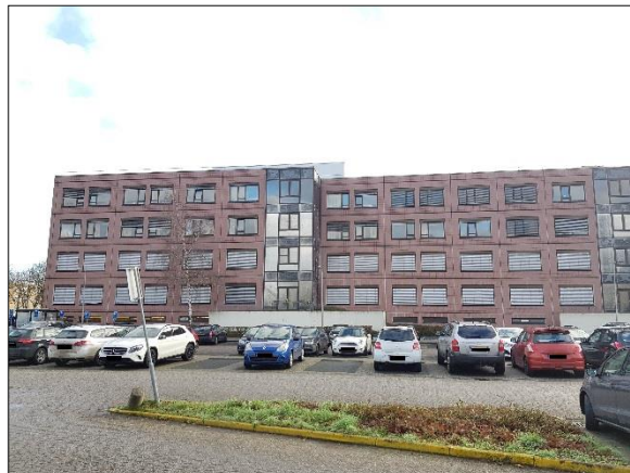
Figuur 5. Hoofdgebouw ziekenhuis met parkeerplaats gezien vanuit westen
