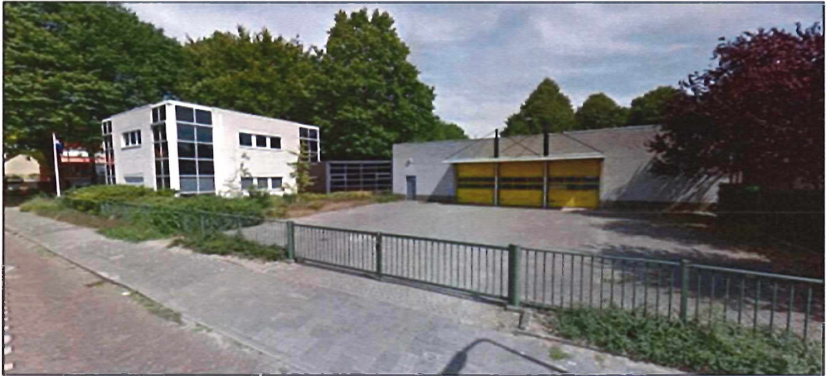
Bestaande situatie met links het kantoorpand en rechts de te slopen bedrijfshal
