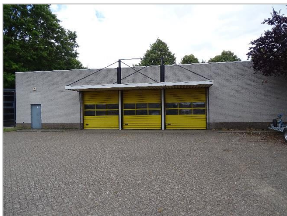
Foto 2: Impressie ligging plangebied Kerkhofweg 119, Breda (westzijde bedrijfshal).
