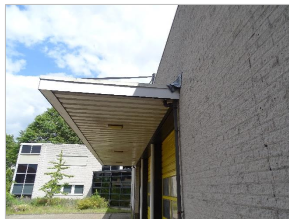
Foto 5: Impressie plangebied Kerkhofweg 119 te Breda (gevel/luifel entree westzijde).
