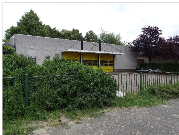
Foto 6: Impressie plangebied Kerkhofweg 119 te Breda (foto vanaf noordwestzijde).
