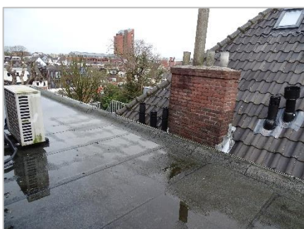
Foto 23: Plat dak en schoorsteen.
