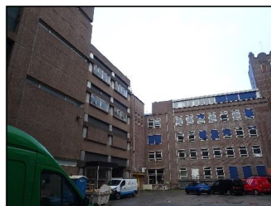
Figuur 8. Noordwestzijde binnenplaats onderzoekslocatie.
