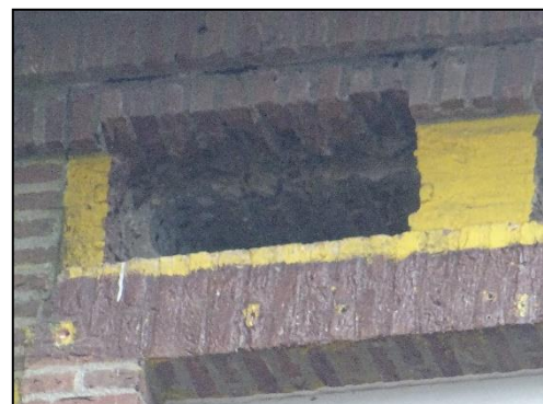
Figuur 9. Opening in de buitengevel (binnenplein) van het zuidelijk deel van het pand.
