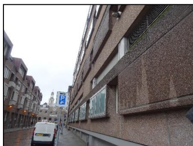
Figuur 6. Westzijde onderzoekslocatie.
