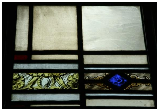
Detail van een van de bovenlichten in de vensters
