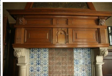
Kap van de schouw en stenen schoren
