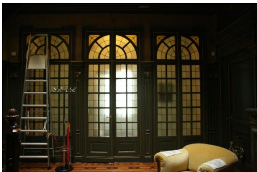
Glazen wand met vleugel deuren naar de gang
