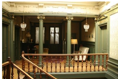
Overloop richting achtergevel
