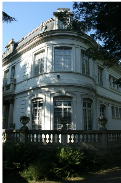
Villa Trianon 2016 voorzijde en rechter zijgevel aan de noordkant
