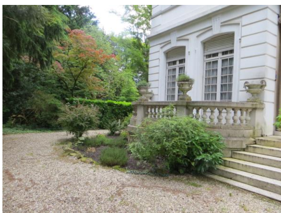
Afb. 1.14: Natuurstenen rand langs de border opzij van de trap naar de hoofdingang in de voorgevel.
