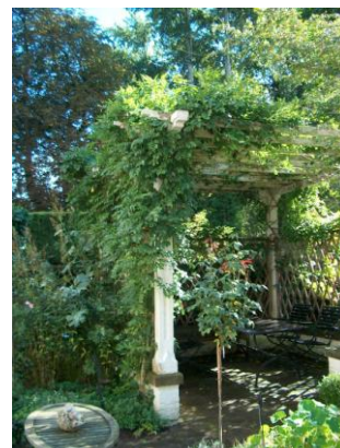
Afb. 3.3 t/m 3.5: Voorbeeld van een begin 20 e eeuwse pergolaconstructie van gewapend beton met het uiterlijk van hout, op een gemetselde plint. Villa Dalhoeve, Lage Duin en Daalseweg 29 te Bloemendaal. (Bron: beeldarchief SB4.)
