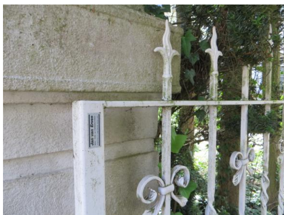
Afb. 1.11: Detailopname van het historiserende hekwerk waarmee de oorspronkelijke openslaande delen van de hoofdpoot zijn vervangen.
