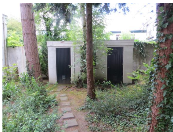
Afb. 1.17: Fietsenberging en betonnen schutting op noordelijke perceelsgrens. Links is nog net de hoek van de kantoorvleugel zichtbaar.
