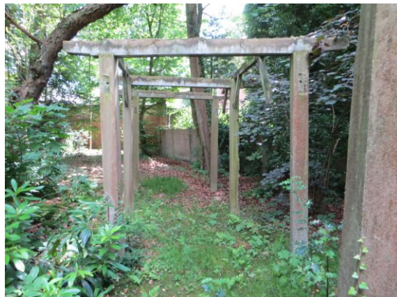
Afb. 1.26: Zicht door de pergola richting het punt waar de hoge gemetselde tuinmuur aansluit op de lagere betonnen schutting.
