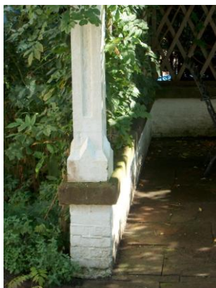
Afb. 3.3 t/m 3.5: Voorbeeld van een begin 20 e eeuwse pergolaconstructie van gewapend beton met het uiterlijk van hout, op een gemetselde plint. Villa Dalhoeve, Lage Duin en Daalseweg 29 te Bloemendaal. (Bron: beeldarchief SB4.)
