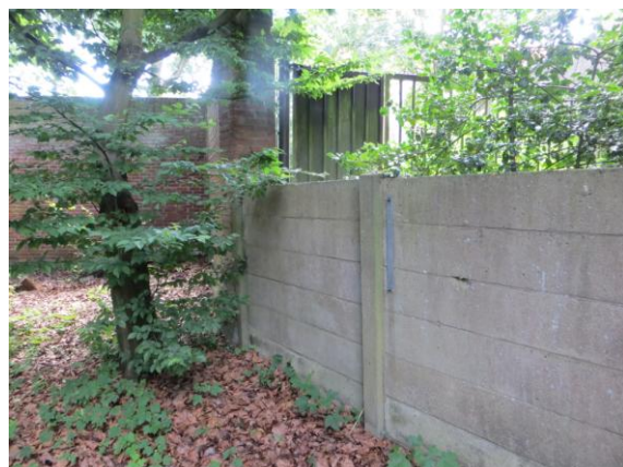
Afb. 1.38: Aansluiting van de hoge gemetselde tuinmuur op de lagere betonnen schutting. Rechts op de achtergrond de stalen poort die het achterpad afsluit vanaf de groenstrook langs de Okeghemlaan.
