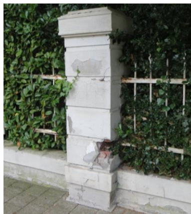
Afb. 1.7: De wit gepleisterde pijlers en plint van het tuinhok zijn vervaardigd uit rode baksteen met stucwerk.
