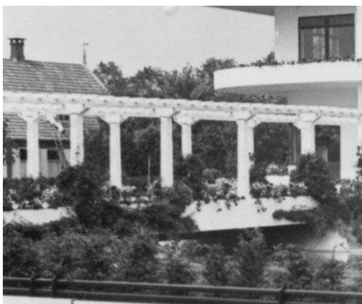
Afb. 3.6: Voorbeeld van een pergola met betonnen staanders en houten liggers. Villa Jongerius aan het Merwedekanaal te Utrecht (Bron: beeldarchief SB4.)
