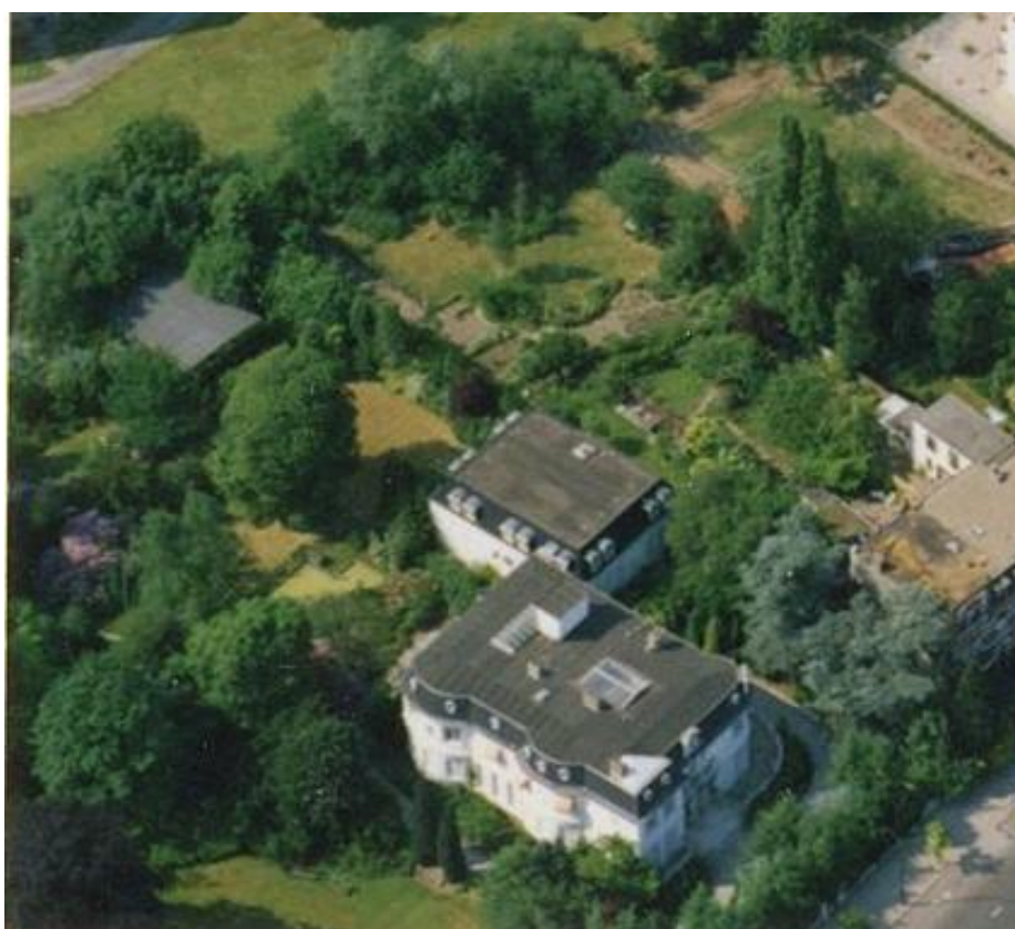
Afb. 2.31: Vogelvluchtopname vanuit het zuidoosten, datum onbekend [na de bouw van de uitbreidingsvleugel in 1978-1979]. (Bron: www.stadsarchief.breda.nl; Breda Beeldcollectie, id.nr. 19902069.)
