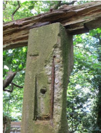
Afb. 1.25: In de betonnen staanders (voorzien van ijzeren frame) zitten gedetailleerde inkepingen als steunpunt voor de houten liggers.
