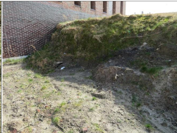
Foto 8 – tegen het stationsgebouw is een geschikte helling voor hopen, toch zijn deze hier niet gezien.
