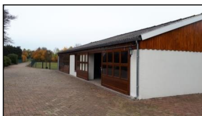
Figuur 4. Schuur ten oosten van het woonhuis op de onderzoekslocatie.
