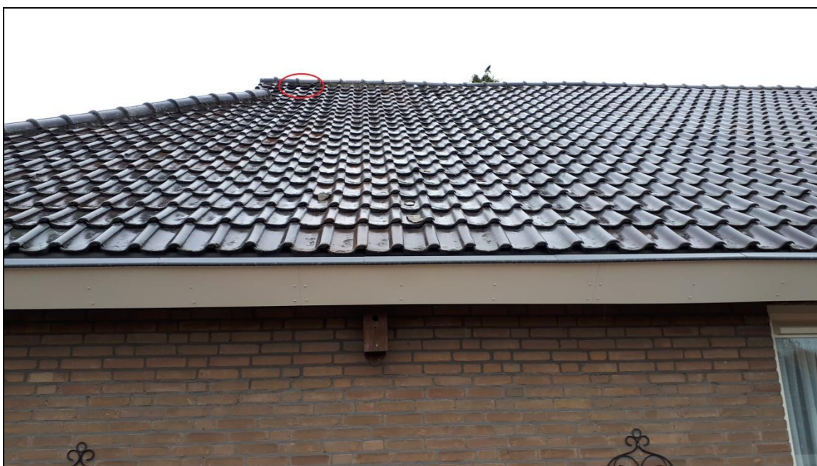
Figuur 14. Nestlocatie van huismussen vlak onder de nok van het dak aan de westkant van het woonhuis op de onderzoekslocatie.
