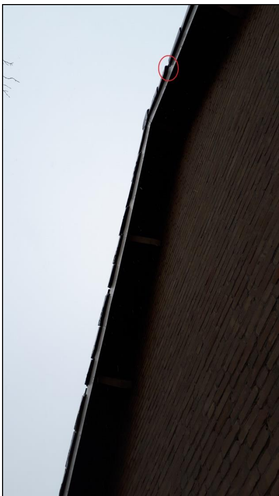
Figuur 12. Nestlocatie van huismussen vlak onder de nok van het dak aan de oostkant van het woonhuis op de onderzoekslocatie.
