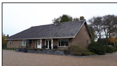
Figuur 3. Woonhuis op de onderzoekslocatie.
