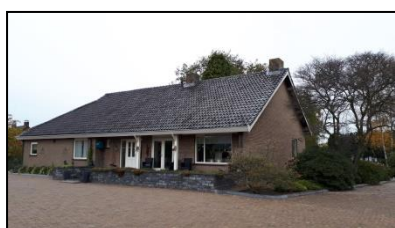
Figuur 3. Woonhuis op de onderzoekslocatie.
