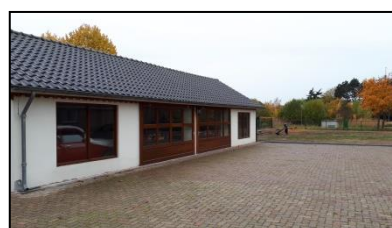
Figuur 5. Schuur ten zuiden van het woonhuis op de onderzoekslocatie.
