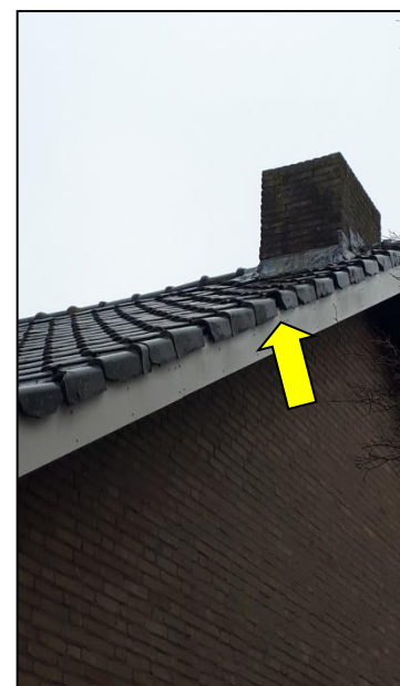
Figuur 10. Geschikte ruimte voor huismussen, gierzwaluwen en vleermuizen onder de dakpannen.
