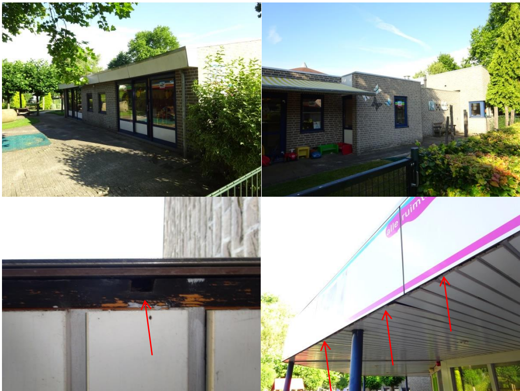
Afbeelding 5: Kinderopvang Kober te Bavel met invliegopeningen (rode pijlen). (bron: Aveco de Bondt, 2016).
