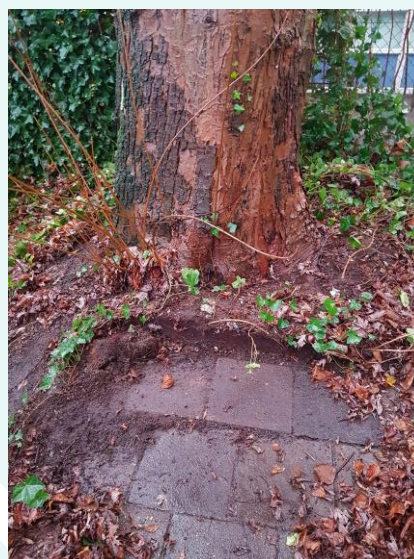
Jongloten en wortelopdruk door te kleine plantspiegel
