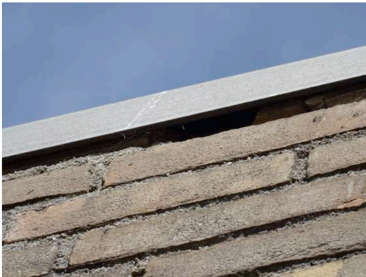
Afbeelding 3: Ruimten onder de metalen dakstrip bieden toegang tot de luchtspouw. Bron: K. van Veen / Ecoresult B.V.
