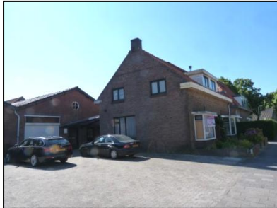
Figuur 3. Woning en zuidelijke loods.
