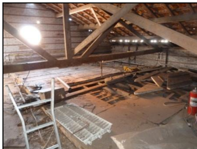
Figuur 10. Binnenzijde zuidelijke loods.
