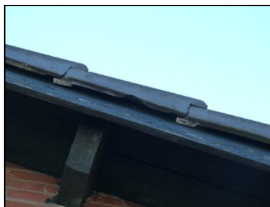
Figuur 13. Dakrand noordelijke loods.
