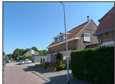
Figuur 8. Westzijde onderzoekslocatie.
