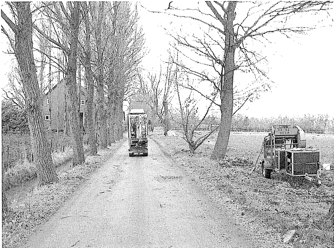
Overzicht van de Lageweg met aan de rechterzijde de asbestzeef.
