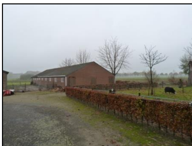
Figuur 6. De noordelijke schuur.
