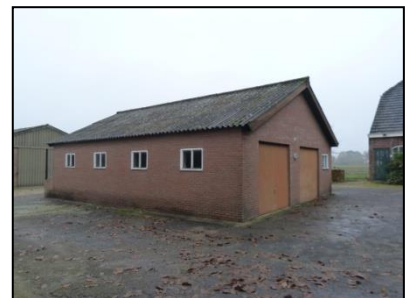
Figuur 5. De centrale schuur op de onderzoekslocatie.
