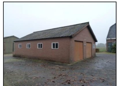
Figuur 5. De centrale schuur op de onderzoekslocatie.
