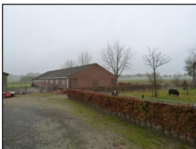
Figuur 6. De noordelijke schuur.
