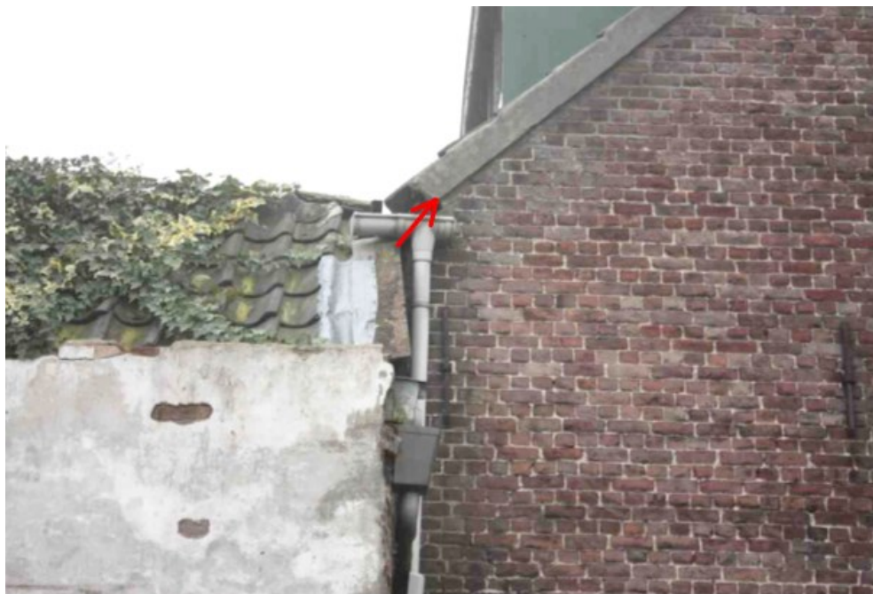
Figuur 5.6. Voor gierwaluw geschikte toegang tot het dak (Bureau Waardenburg, 2015).
