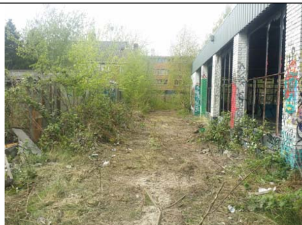
Foto 3; richting PB05, achterkant loods nr. 108
