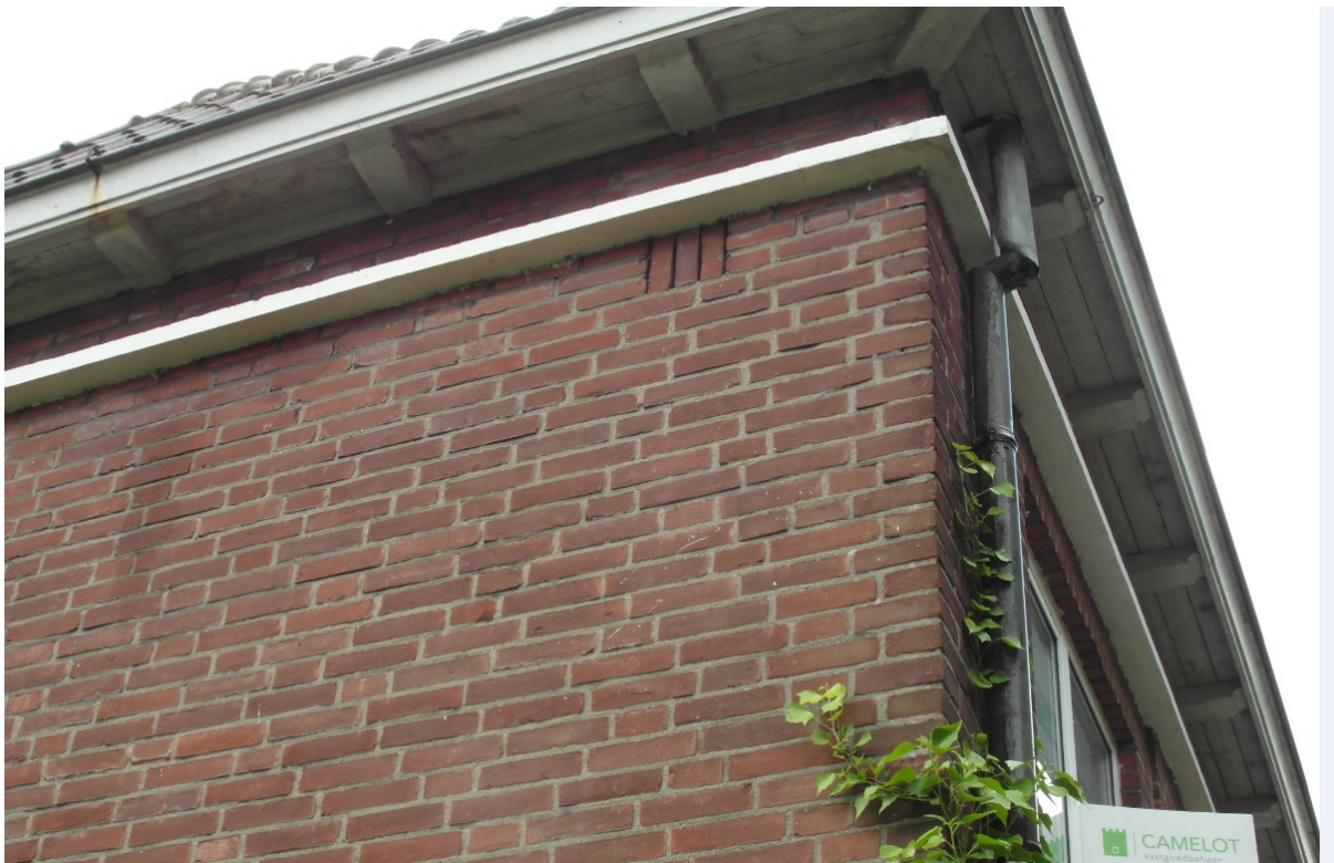
Foto 1 afgesloten roostervoegen huisnummer 106.
