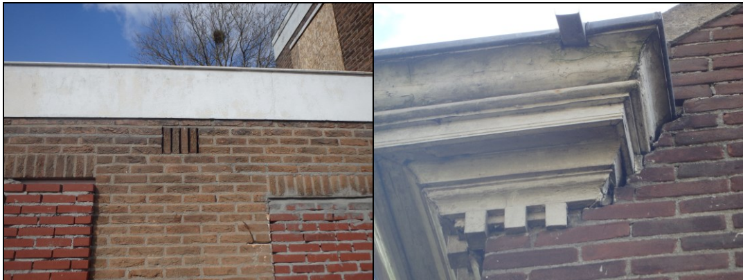
Figuur 5.7. Impressie potentiële verblijfplaatsen van vleermuizen. Links: woning Beverweg 110. Rechts: woning Teteringsedijk 126.
