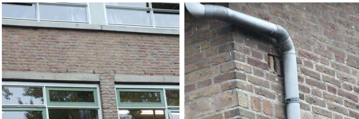
Figuur 4. Geschikte invliegopeningen voor vleermuizen in de bestaande bebouwing (links spouwmuur ter hoogte van nieuwe loopbrug, rechts spouwmuur te verwijderen woning).
