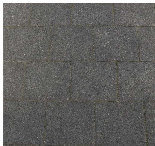
betontegels 30x30 cm met basaltine toplaag
