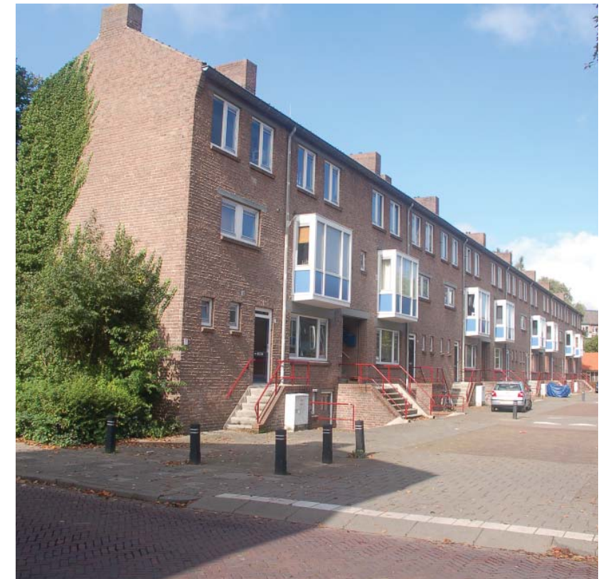
De Hudsonstraat, het noordelijke deel. Bouwblok met erkers.
