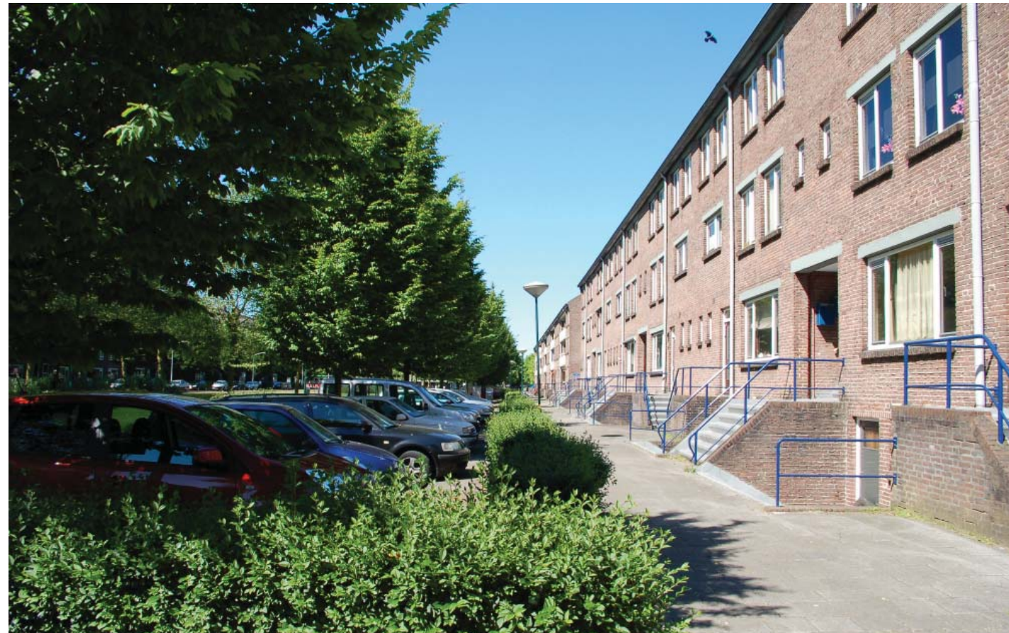
Planciusplein met aangrenzende bebouwing.
