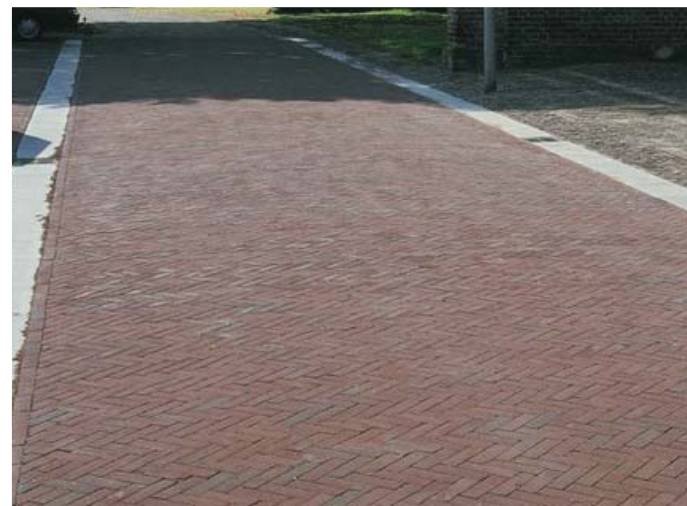
rood gebakken klinkers met lichte opsluitband in rijwegen
