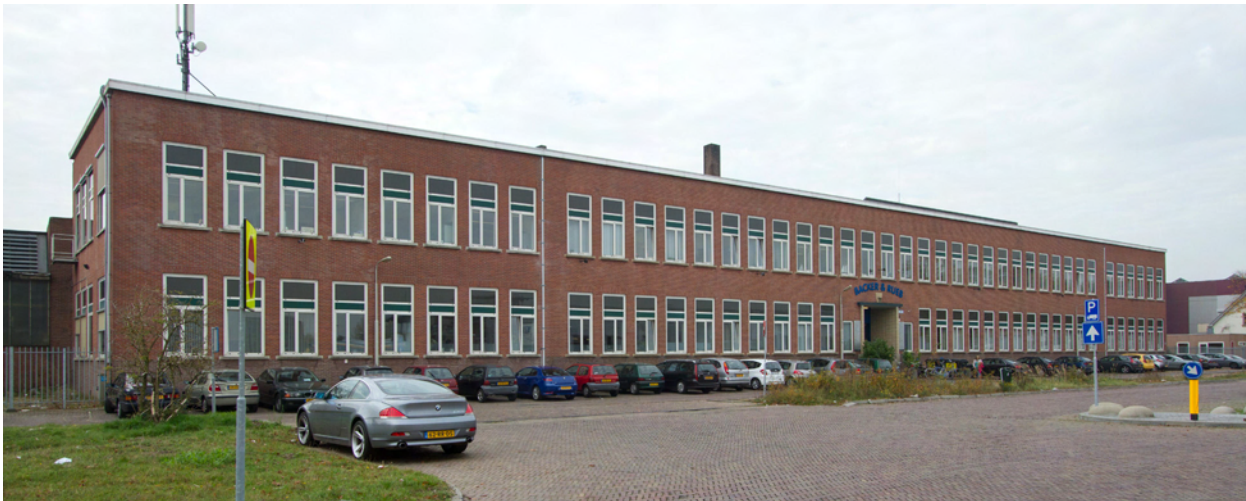
Afb. 15 Kantoor van de firma Backer & Rueb, helaas met niet-historische vensterindelingen.
