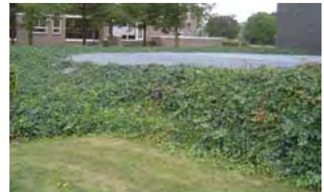
Ventilatieopeningen met beplanting
