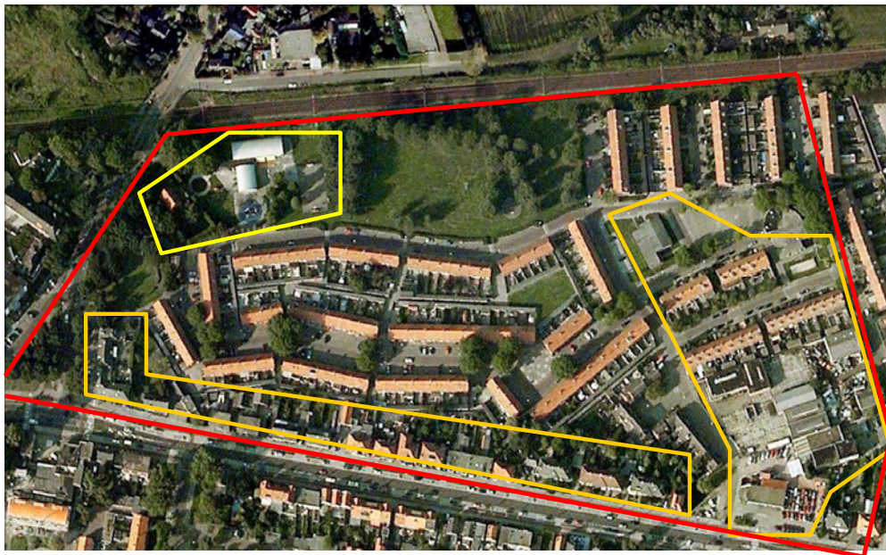
Figuur 1: Plangebied 'De Driesprong' in Breda (binnen de rode contour). Binnen de gele lijnen liggen de woningen die gerenoveerd of gesloopt gaan worden.
