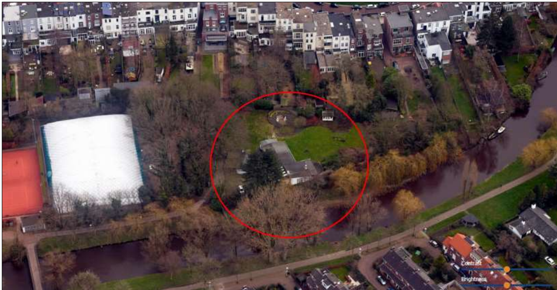
Luchtfoto van het perceel met de inmiddels grotendeels gesloopte woning
