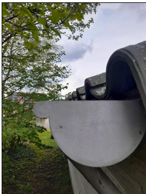
Figuur 7. De dakpannen zijn toegankelijk via de dakgoot.
