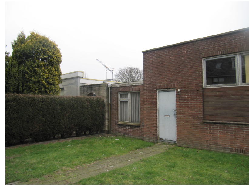
bestaande toestand foto 2
