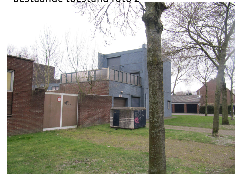
bestaande toestand foto 1
