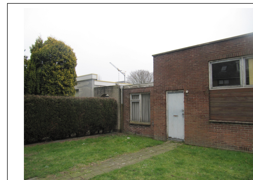
bestaande toestand foto 2
