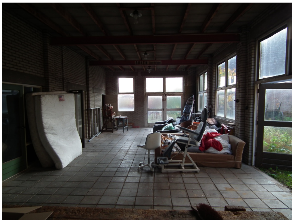
Figuur 2 De planlocatie bestaat deels uit een bedrijfsgebouw bestaande uit een hal, toiletruimte en verschillende kleine opslagruimtes.
