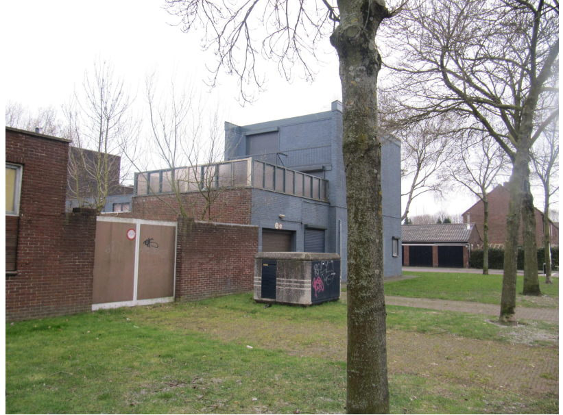
bestaande toestand foto 1
