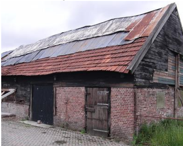
Monumentale schuur wordt op den duur gerestaureerd.
