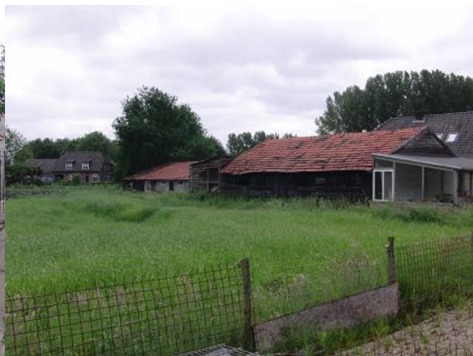
Achterkant bestaande schuur.
