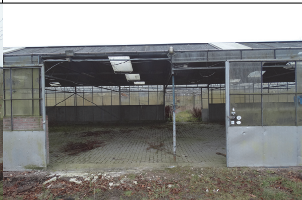
Figuur 8: Aanzicht te slopen kassencomplex
