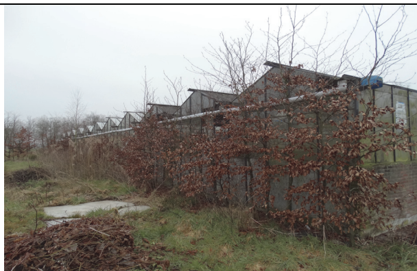
Figuur 7: Te slopen kassencomplex met beukenhaag ervoor
