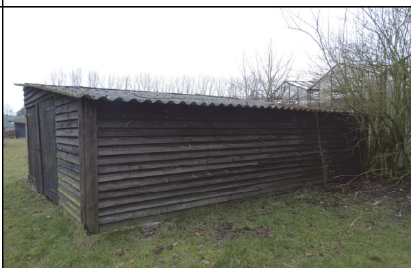
Figuur 12: Voorzijde van het te slopen schuurtje
