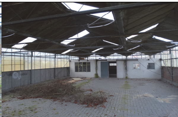
Figuur 10: Kantoorruimte in het te slopen kassencomplex
