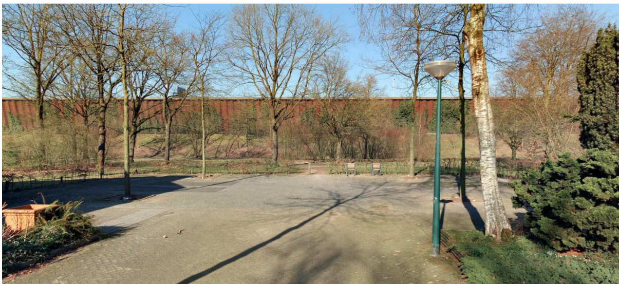
Scherf van ca. 10 meter hoogte met een parkzone op ca. 50 meter vanaf het scherm.
