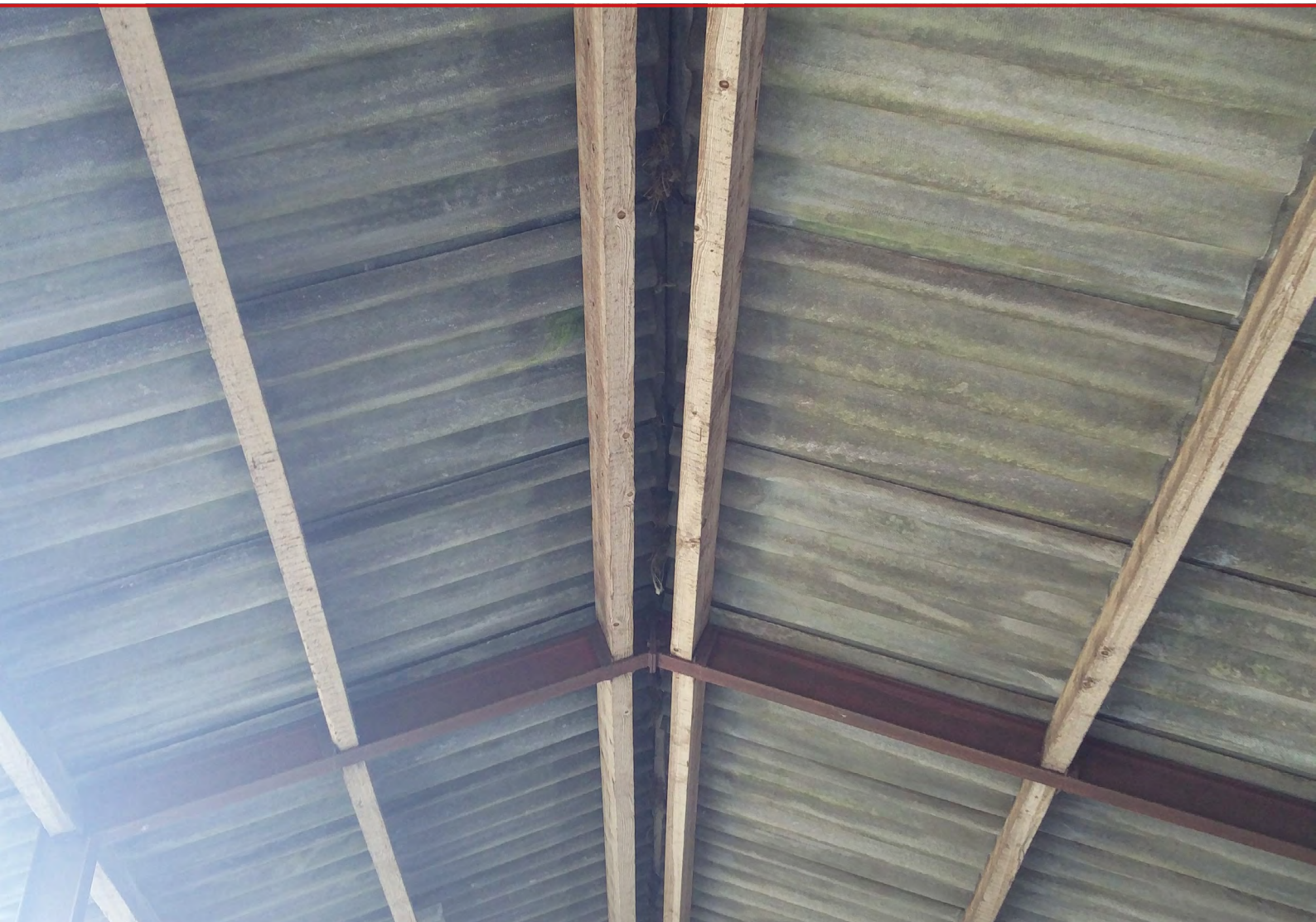
Kapschuur met sporen van nesten in het midden van het dak.
