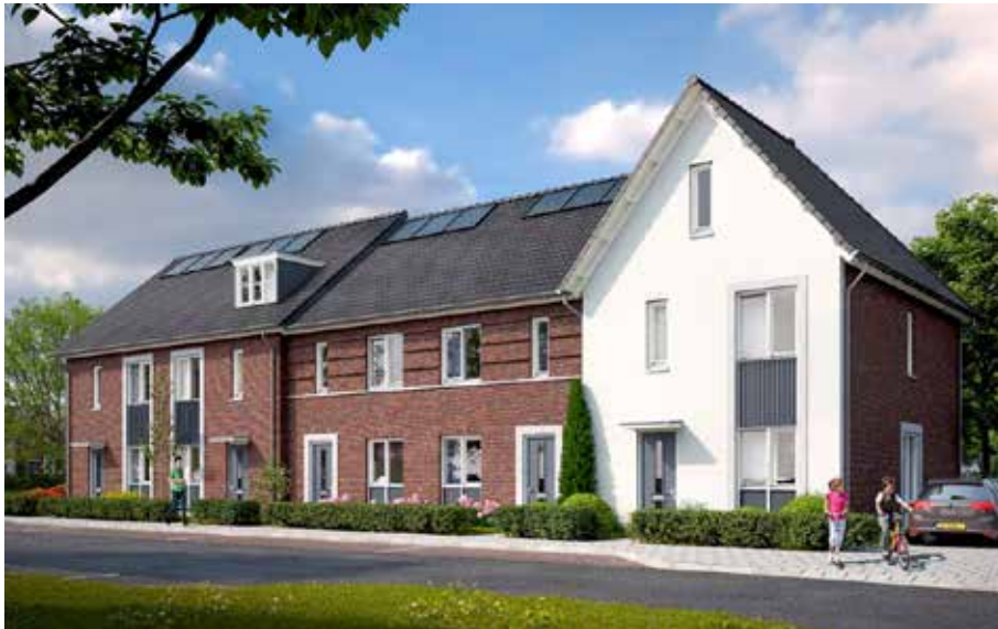
Variatie in blok door kleine inspringingen, een gedraaide kap, positie en vorm van ramen, details en kleur
