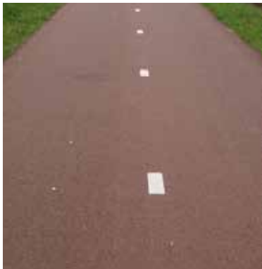
Fietspad Weikespad: rood asfalt
