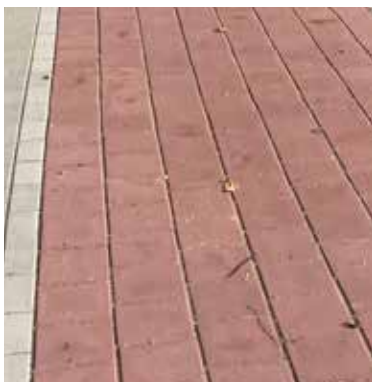
Fietspad: rode betontegels
