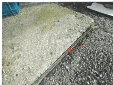
Aanzicht vlakke plaat, verlorenbekisting terrein
