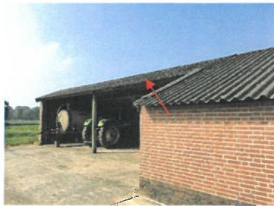
Aanzicht golfplaat, dak aanbouw
