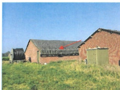
Aanzicht golfplaat, dak stal 5
