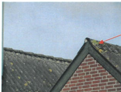
Aanzicht nok, dak stal
