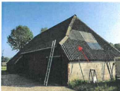
Aanzicht golfplaat, dak stal 1
