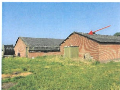
Aanzicht nok, dak stal 4
