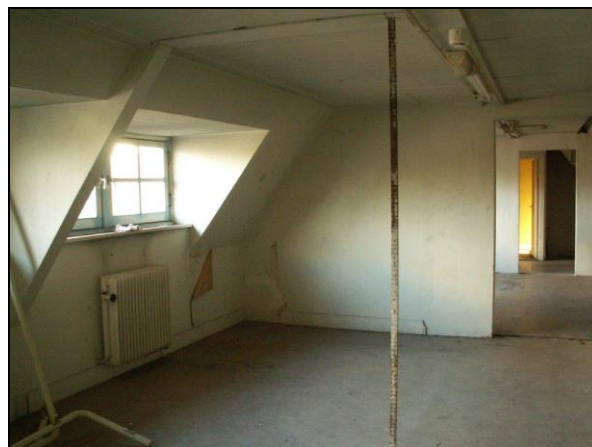
Zolderruimte die niet of nauwelijks geschikt is voor vleermuizen.
