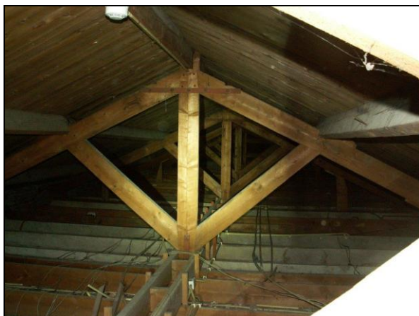
Zolderruimte met verblijfmogelijkheden voor vleermuizen.
