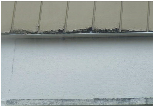
Fig. 7. Foto van een van de kopse kanten van de rijtjeswoningen. Op de kopse kanten zijn platen die als dakbeschoot zijn bevestigd. ER zijn meerdere openingen in dit dakbeschoot.
