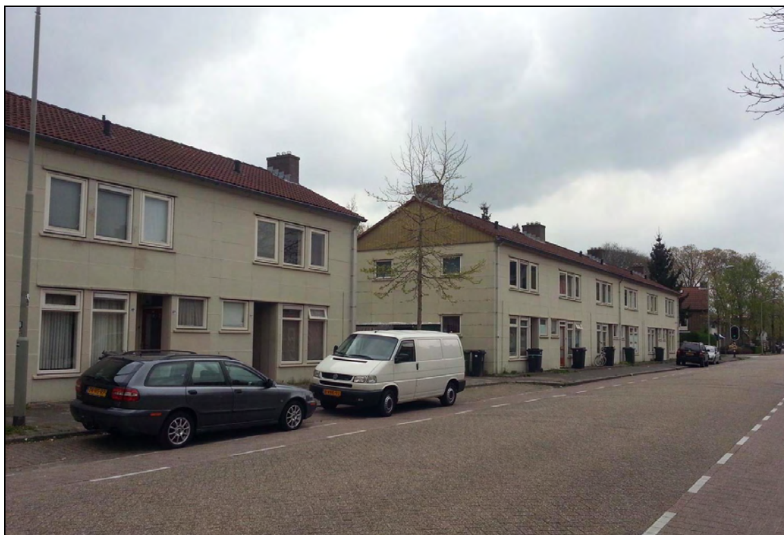
Figuur 10: Zicht op het plangebied aan de Van Hugenpothstraat. De huizen worden gesloopt ten behoeve van nieuwbouw. Foto genomen in noordwestelijk richting.
