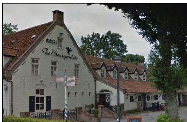
Aanzicht van het pand aan de Bosscheweg 133, gezien vanuit het noordoosten.
