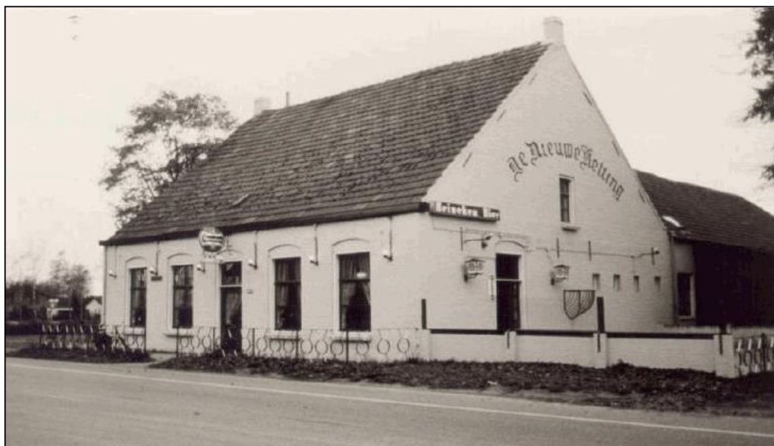
Aanzicht van het pand aan de Bosscheweg 133
