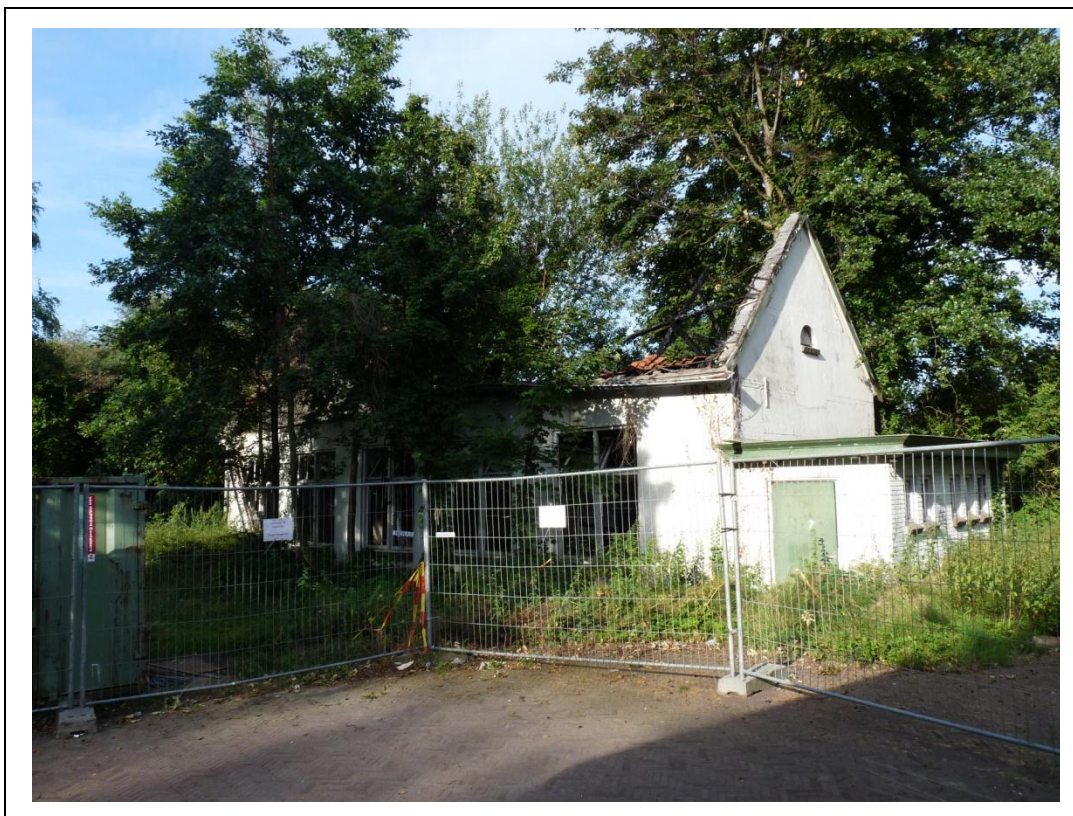
Foto 2. Vervallen gebouw aan de westzijde van de onderzoekslocatie.
